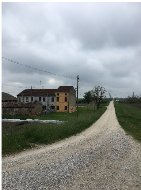
Figura 5 – Vista del ricettore e della strada sotto cui interrare il cavidotto
