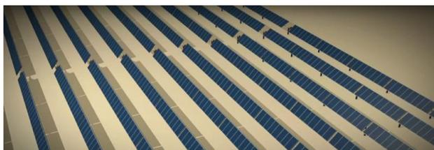
**Figura 4- Esempio di inseguitore monoassiale**
