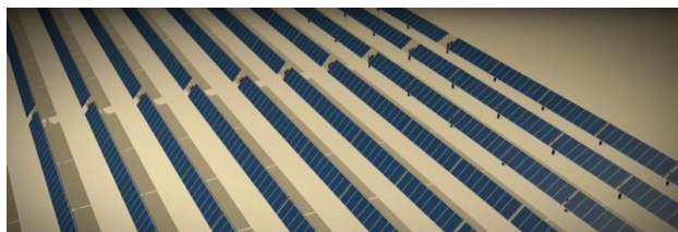
Figura 4- Esempio di inseguitore monoassiale
