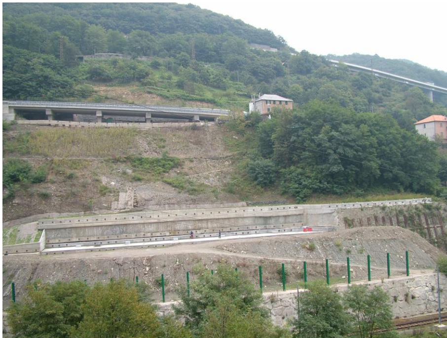
Figura 18 – Foto frontale della sistemazione provvisoria del versante a lavori ultimati.
