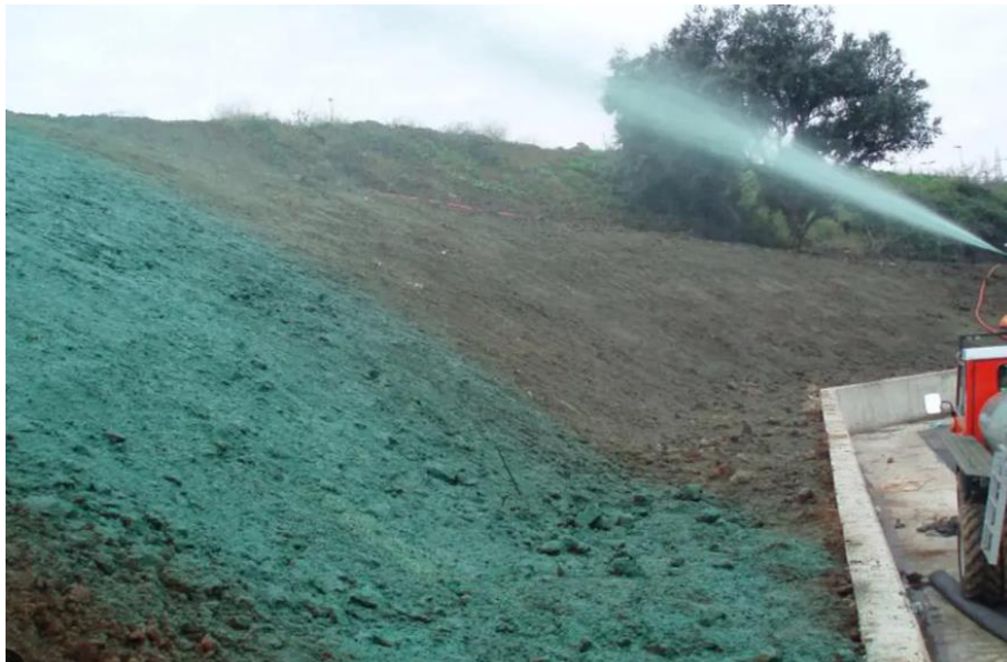
Figura 44 – Foto di intervento di rinverdimento di una scarpata con idrosemina.
