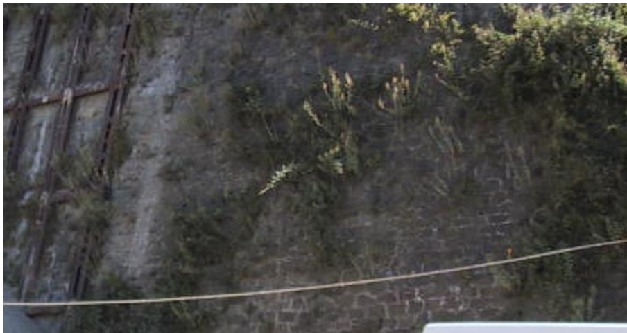
Figura 40 – Muratura delle opere preesistenti.
