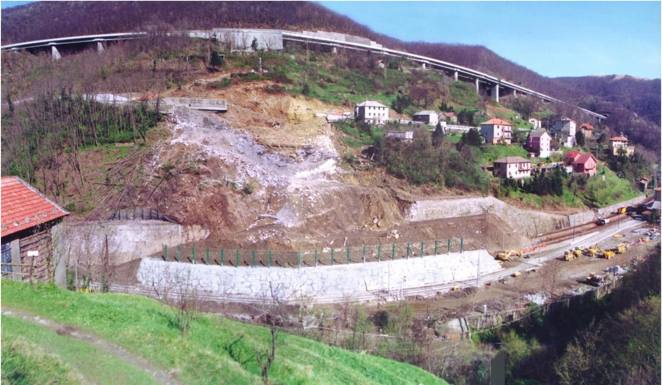
*Figura 2 Effetto del movimento franoso, messa in sicurezza dell'asse dei binari attraverso la realizzazione di una paratia a valle (in primo piano).*
