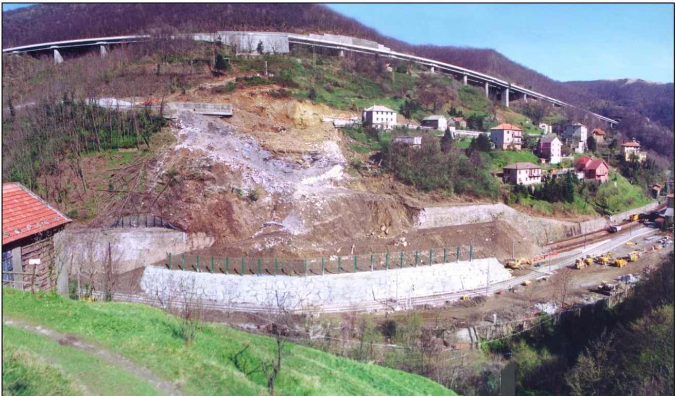
Figura 8 – Foto frontale della frana avvenuta nel Novembre 2000.
