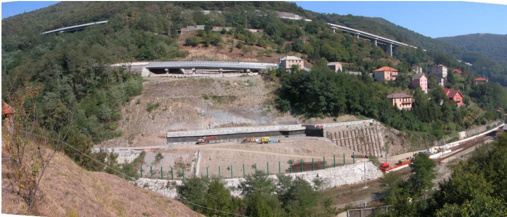
Figura 17 – Foto frontale della sistemazione provvisoria del versante durante i lavori.
