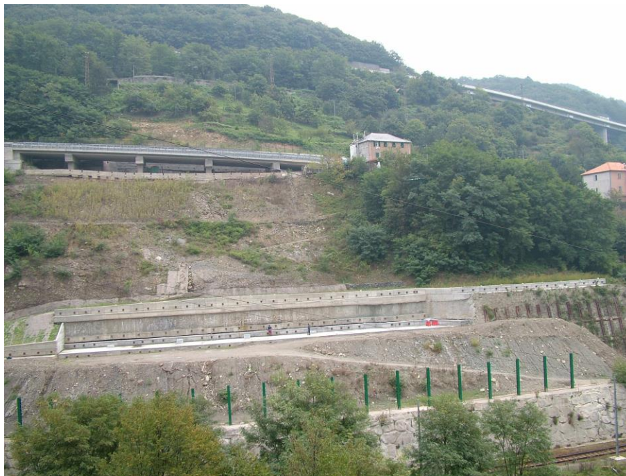
Figura 18 – Foto frontale della sistemazione provvisoria del versante a lavori ultimati.
