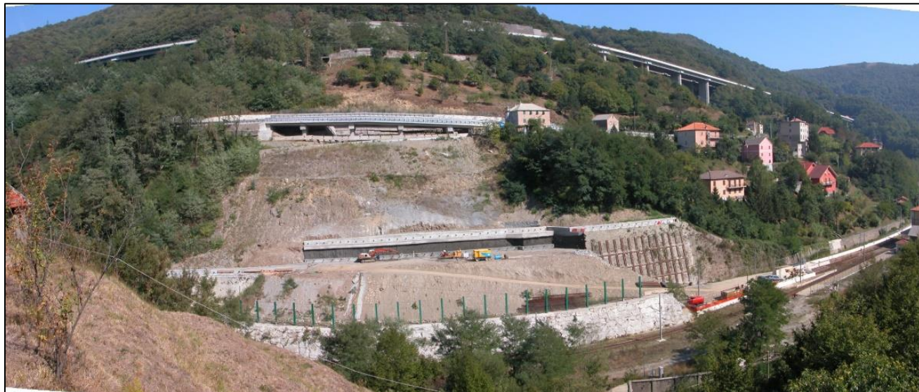
Figura 9 – Foto frontale della sistemazione provvisoria del versante ad ultimazione lavori.
