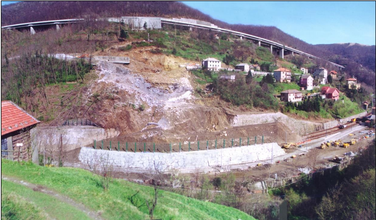
Figura 8 – Foto frontale della frana avvenuta nel Novembre 2000.
