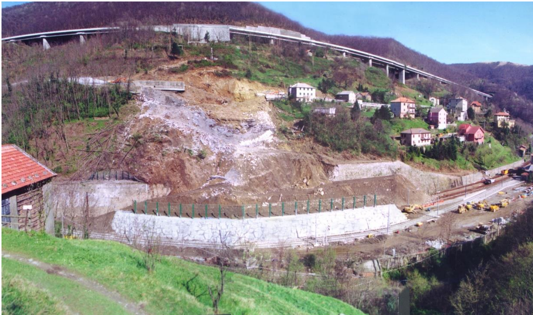
Figura 11 – Foto frontale della frana avvenuta nel Novembre 2000.
