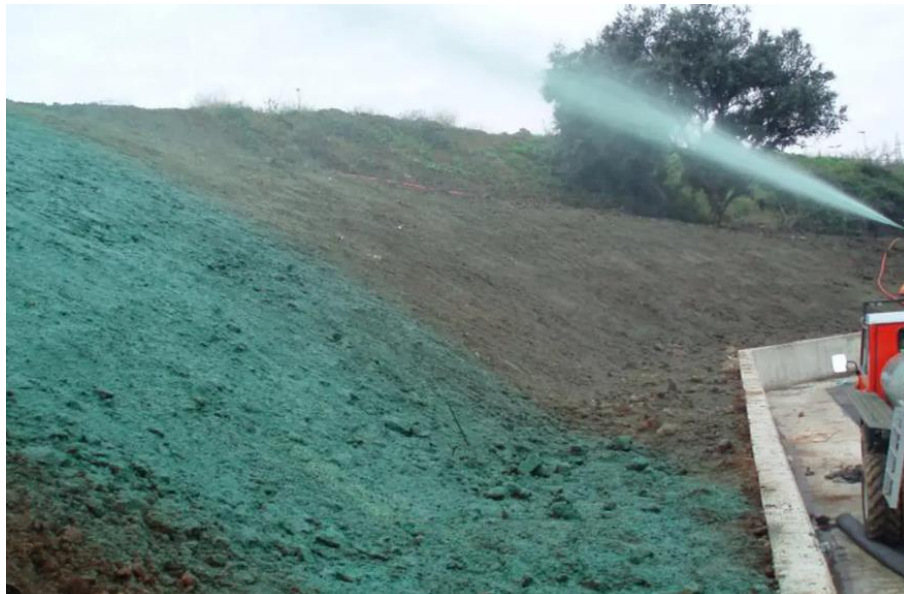
Figura 30 – Foto di intervento di rinverdimento di una scarpata con idrosemina.
