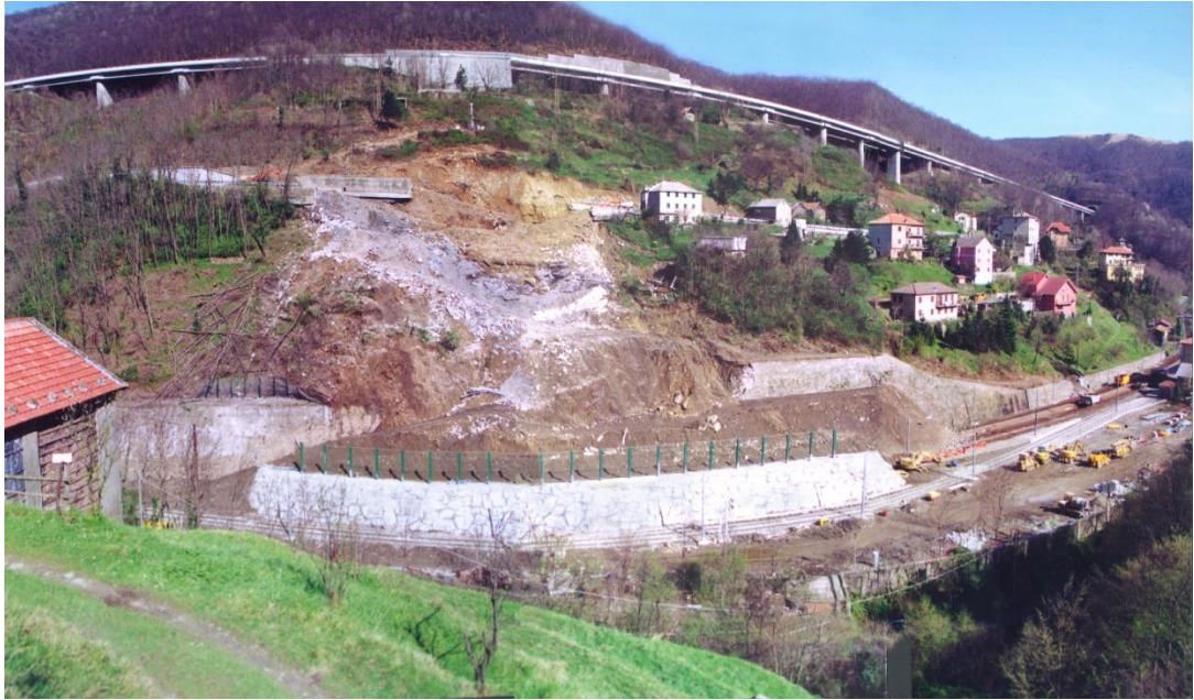
Figura 2 – Foto frontale della frana avvenuta nel Novembre 2000.
