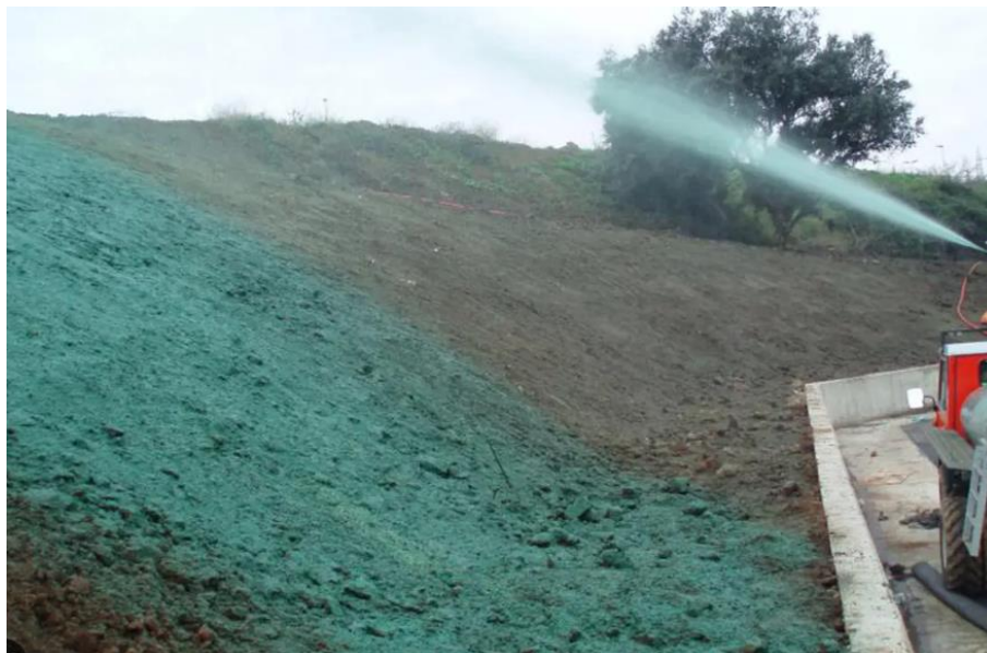
Figura 28 – Foto di intervento di rinverdimento di una scarpata con idrosemina.
