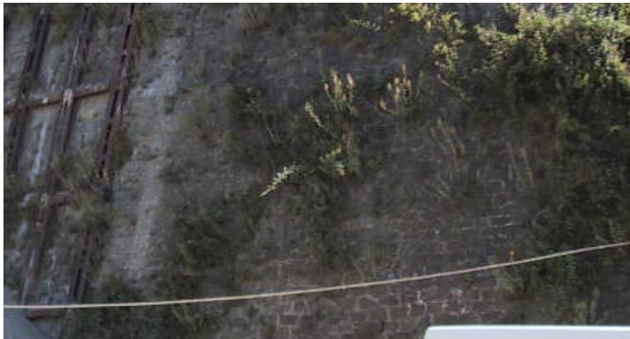
Figura 24 – Muratura delle opere preesistenti.
