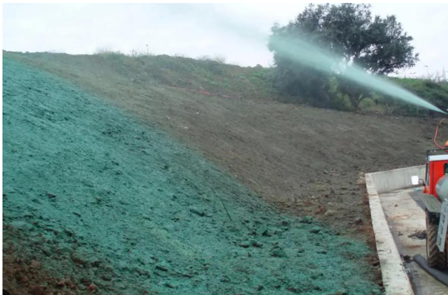
Figura 27 – Foto di intervento di rinverdimento di una scarpata con idrosemina.
