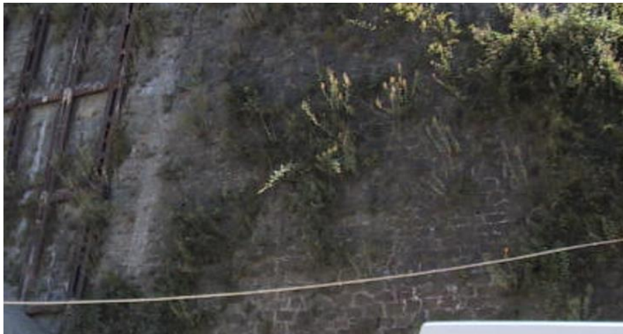
Figura 23 – Muratura delle opere preesistenti.
