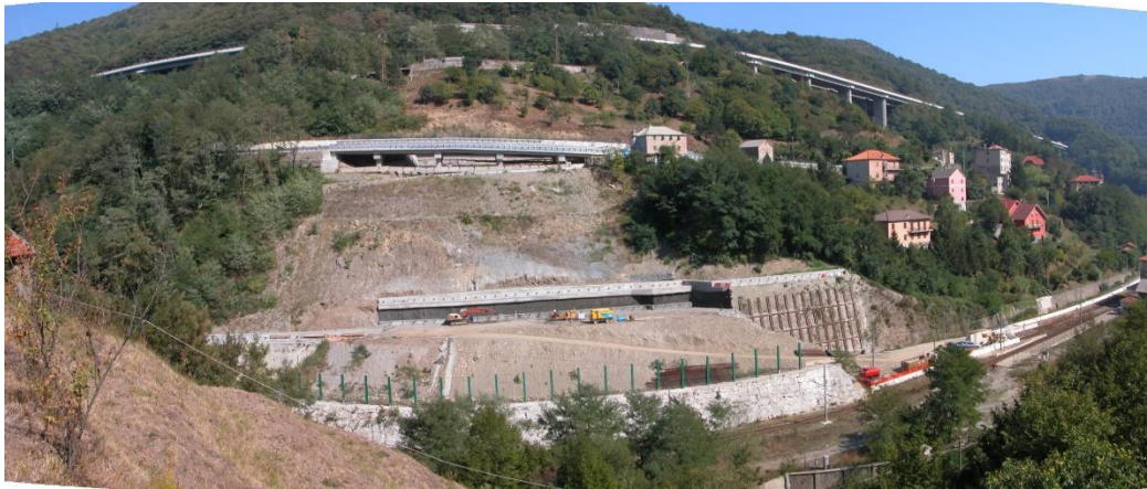
Figura 4 – Foto frontale della sistemazione provvisoria del versante ad ultimazione lavori.
