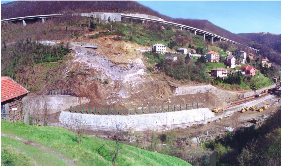
Figura 3 – Foto frontale della frana avvenuta nel Novembre 2000.
