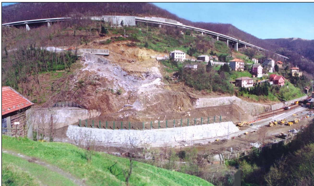
Foto frontale della frana avvenuta nel Novembre 2000.
