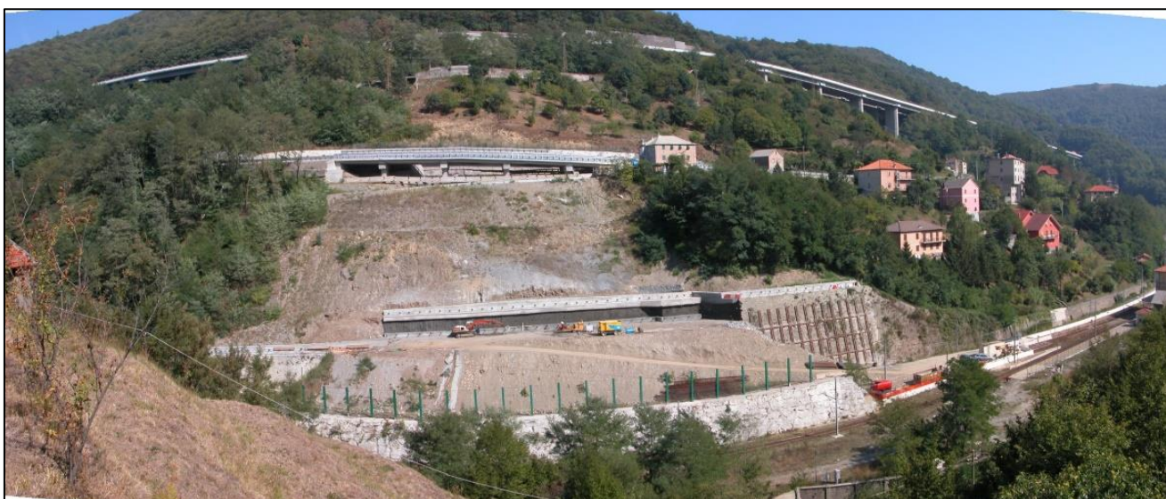
Foto frontale della sistemazione provvisoria del versante ad ultimazione lavori.
