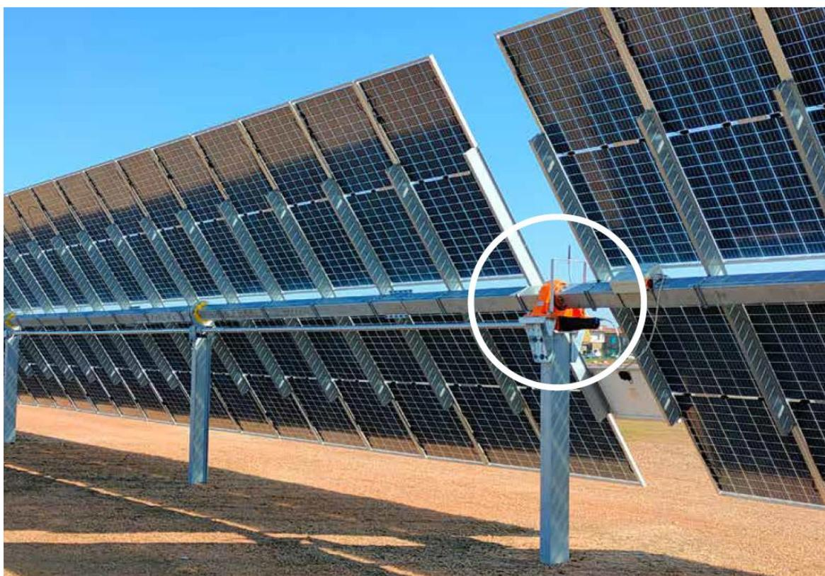
Figura 10 - immagine esemplificativa di inseguitori mono-assiali in configurazione 2P (fonte: Soltigua)
