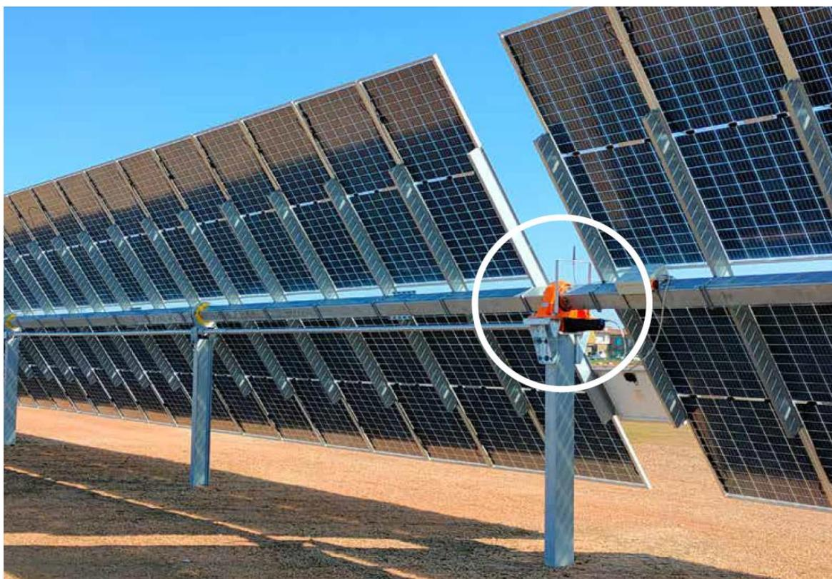
Figura 4 - immagine esemplificativa di inseguitori mono-assiali in configurazione 2P (fonte: Soltigua)
