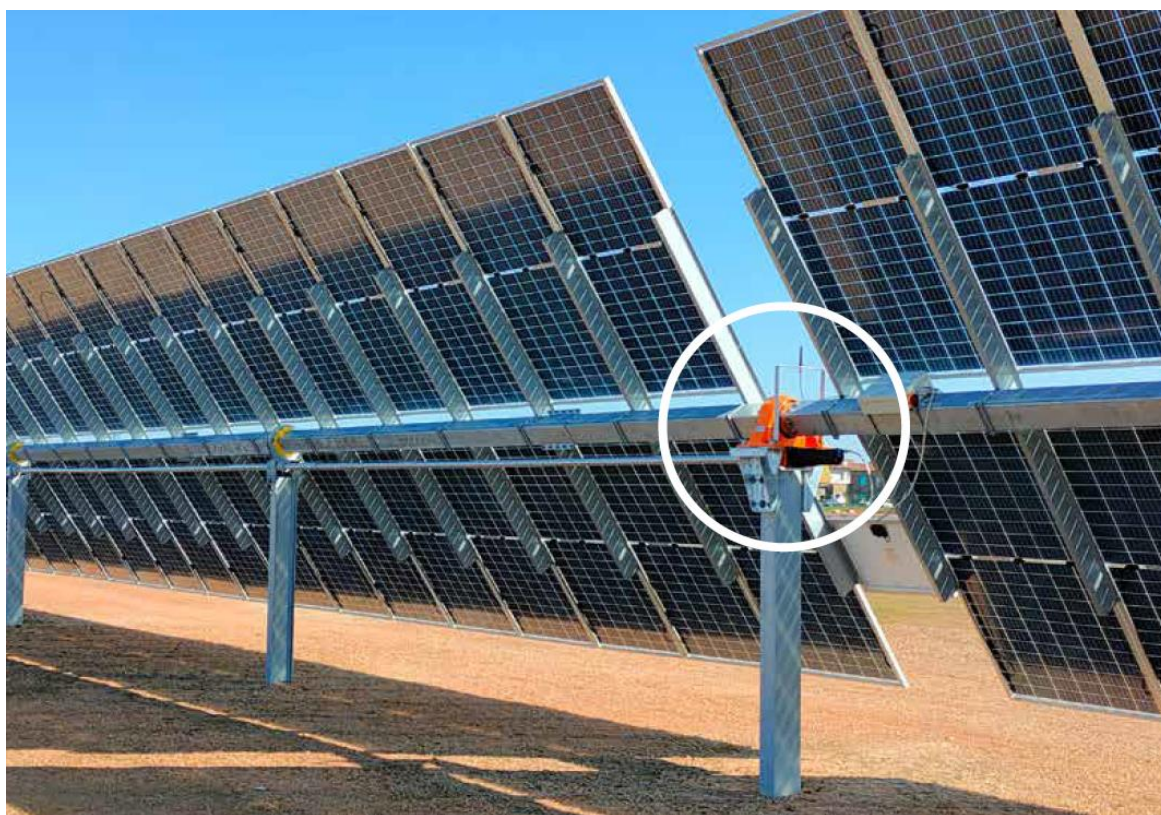
Figura 2 - immagine esemplificativa di inseguitori mono-assiali in configurazione 2P (fonte: Soltigua)
