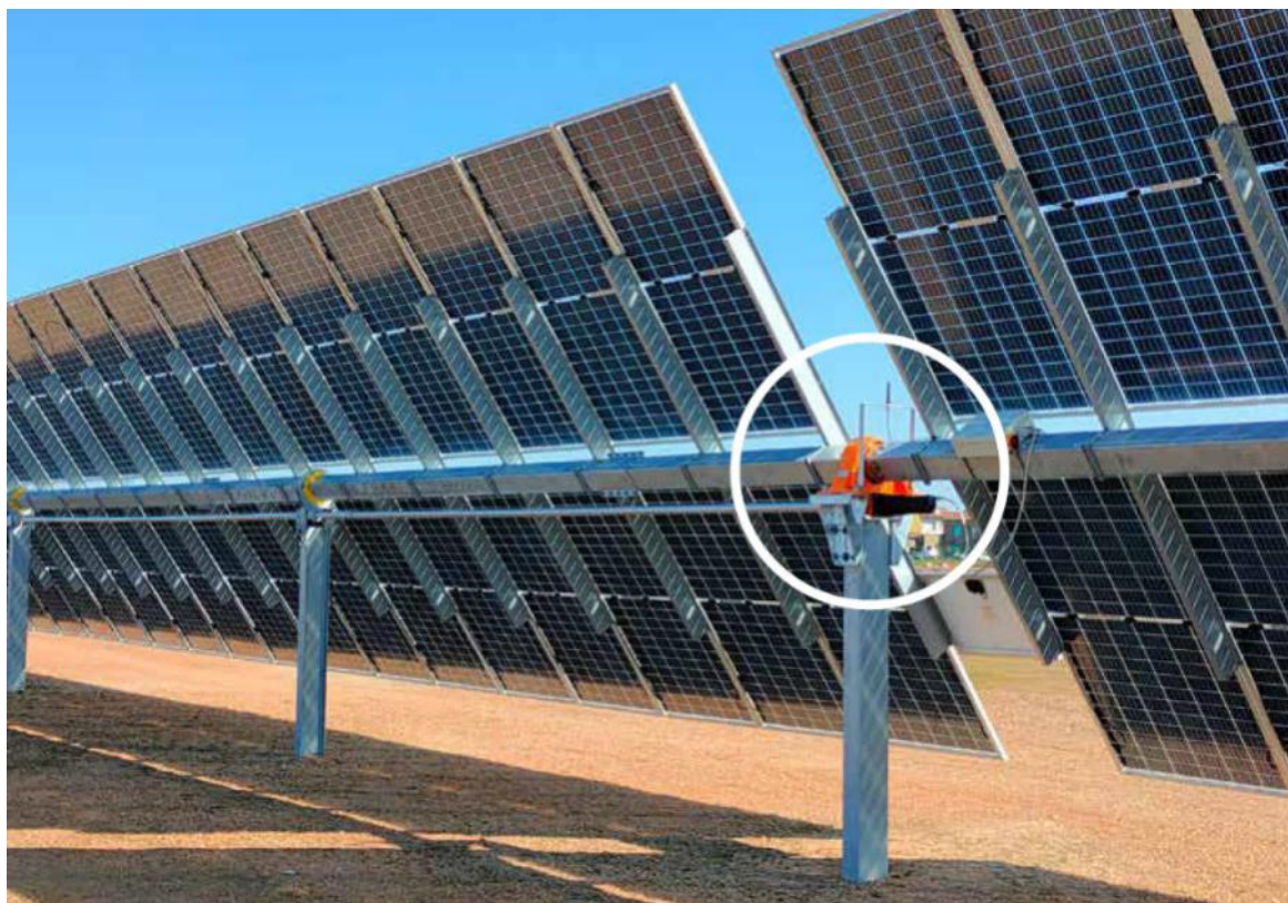
Figura 4 - immagine esemplificativa di inseguitori mono-assiali in configurazione 2P
