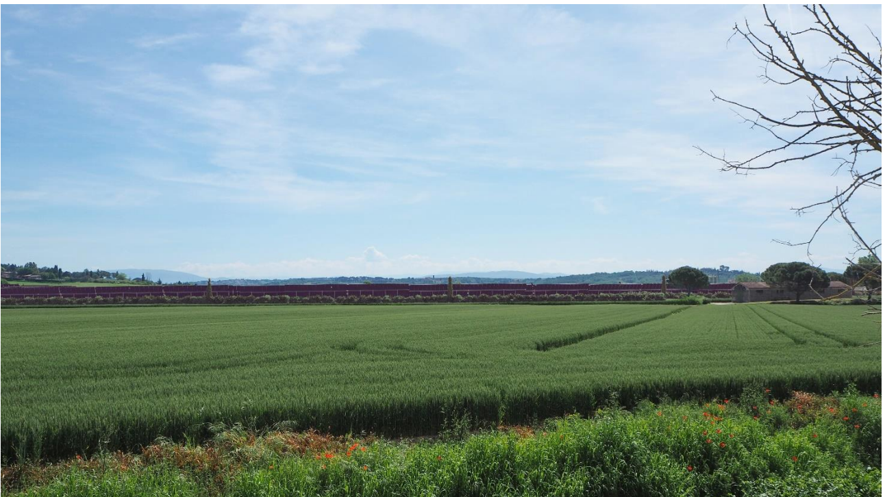
Figura 6.9 – Vista n. 4 sull'impianto fotovoltaico da perimetro esterno (post operam)
