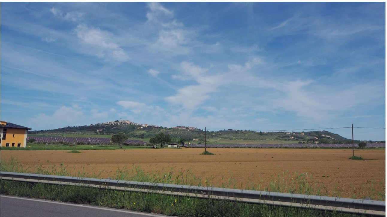
Figura 6.5 – Vista n. 2 sull'impianto fotovoltaico da perimetro esterno (post operam)
