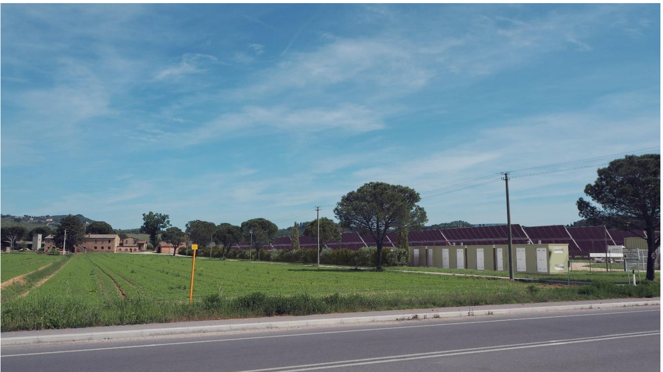
Figura 6.3 – Vista n. 1 sull'impianto fotovoltaico da perimetro esterno (post operam)
