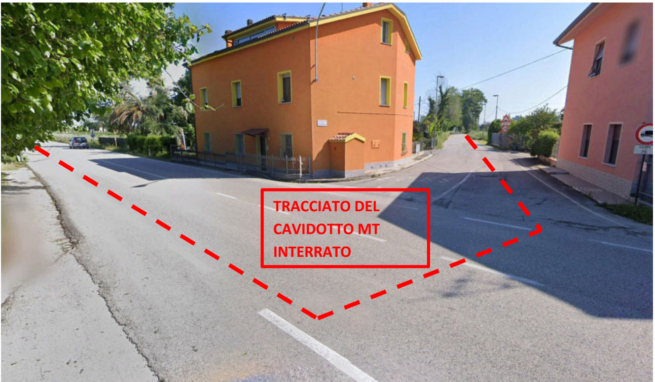
Foto 6 – Raggiungimento sottostazione elettrica, passaggio da SP Sirolo Senigallia A Via del Molino
