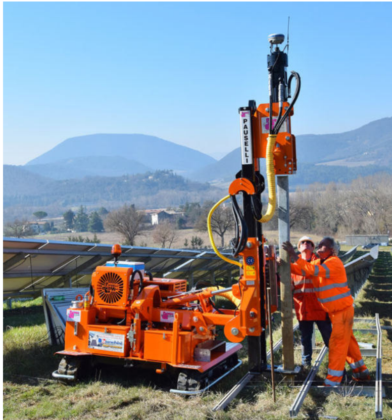
Mezzo operatore per l'infissione dei pali di sostegno dei moduli fotovoltaici
