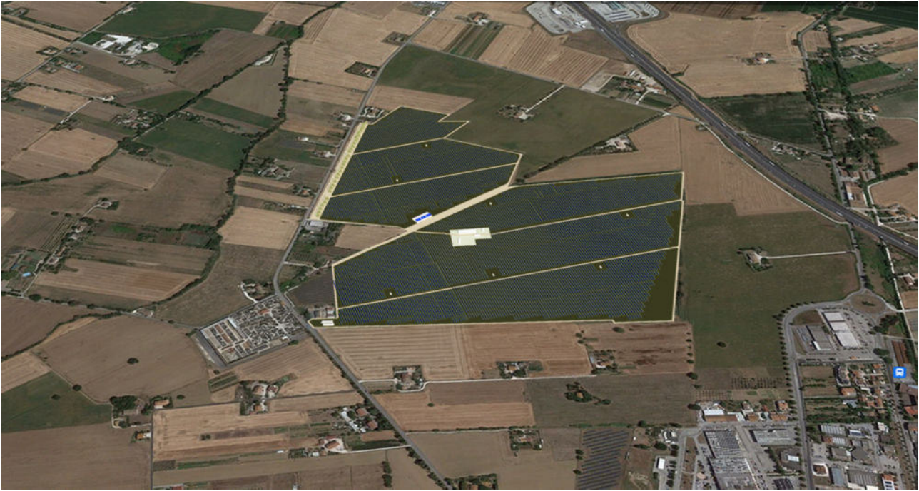
Vista dell'impianto a volo d'uccello
