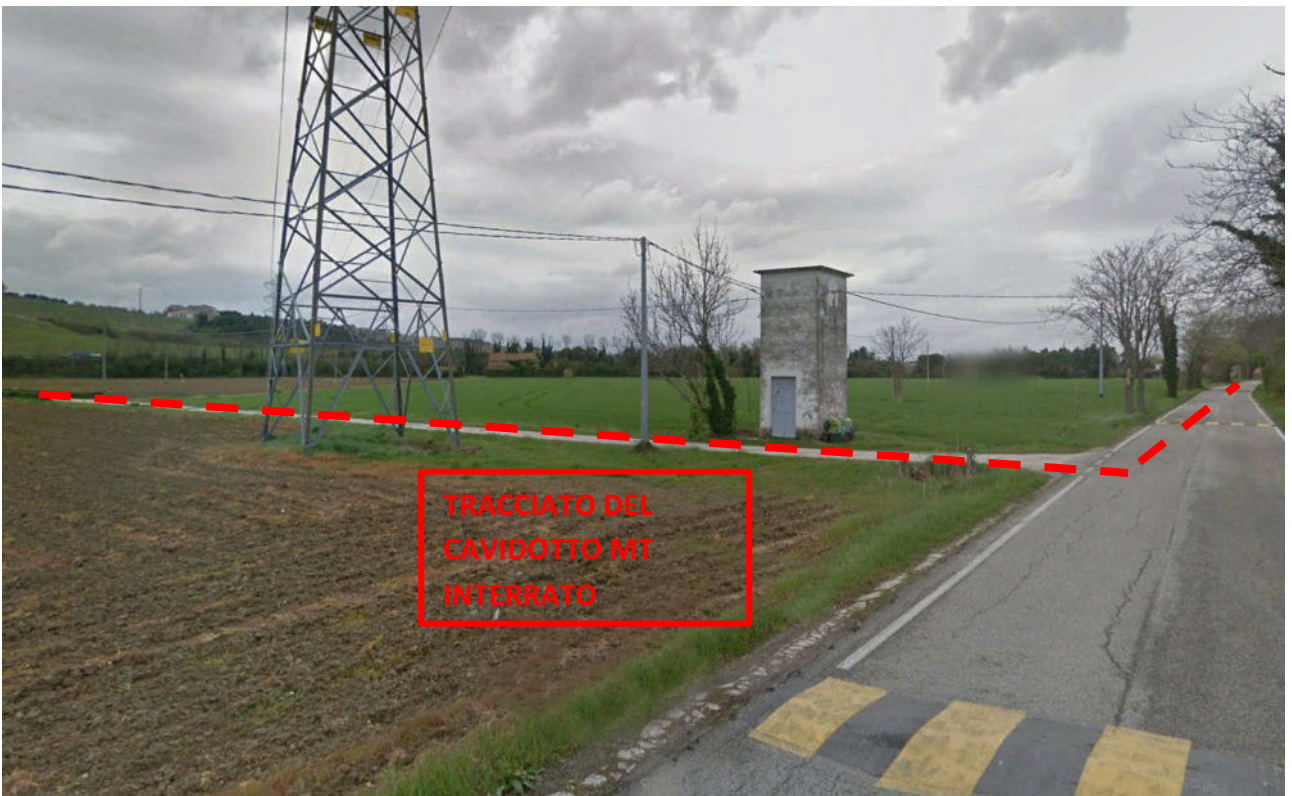
Foto 7 – Raggiungimento sottostazione elettrica
