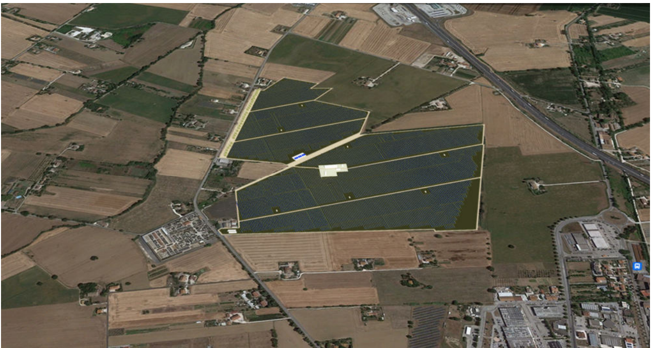
Vista dell'impianto a volo d'uccello
