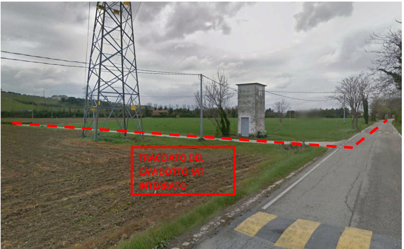
Foto 7 – Raggiungimento sottostazione elettrica
