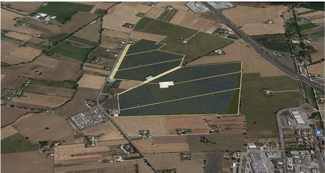
Vista dell'impianto a volo d'uccello
