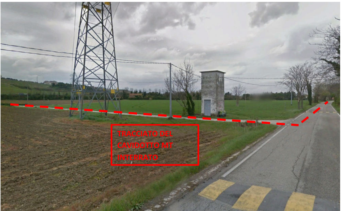
Foto 7 – Raggiungimento sottostazione elettrica
