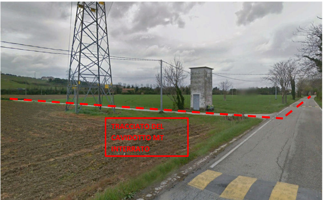
Foto 7 – Raggiungimento sottostazione elettrica
