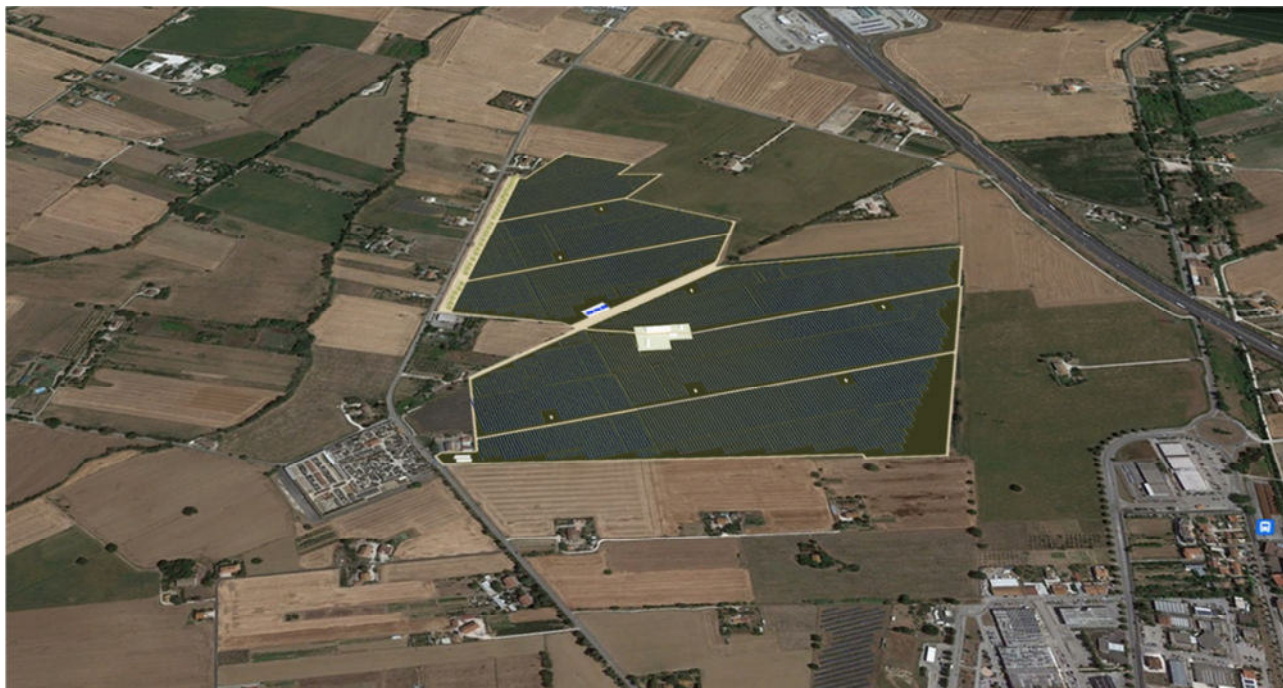
Vista dell'impianto a volo d'uccello
