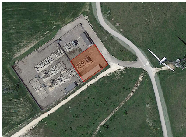
Fig. 4 Sottostazione di Alberona della IVPC (area di colore rosso) A sinistra la SE-RTN di Terna e in alto la sottostazione di altro produttore
