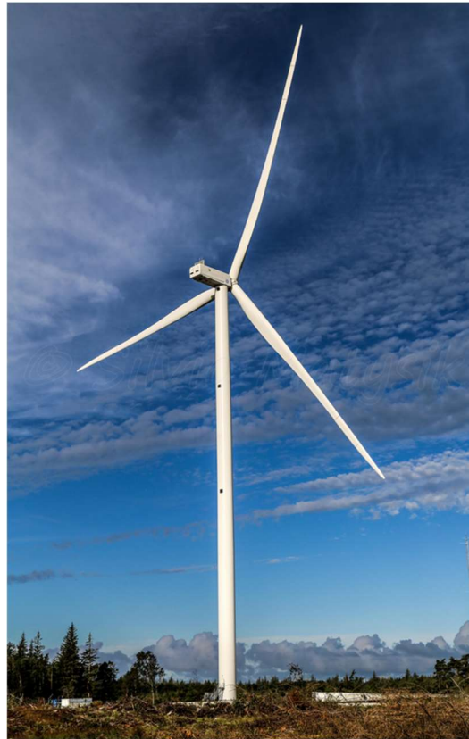
Fig. 14 Un aerogeneratore GE 158 da 6,1 MW in esercizio
