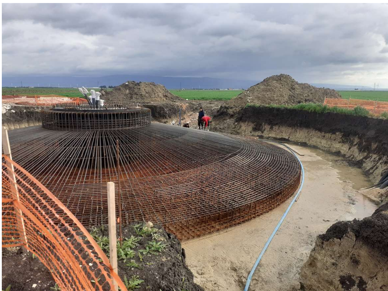
Fig. 23 Armatura di acciaio del plinto di fondazione.
