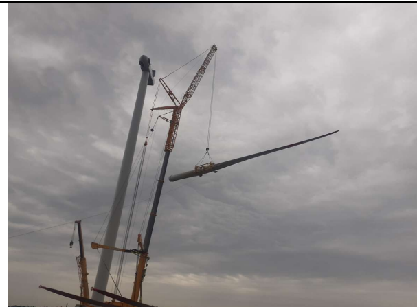
Esempio di sollevamento di blade
