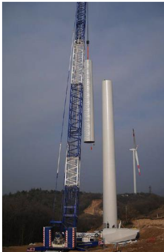
Figura 8. Operazione di montaggio di una torre eolica.
