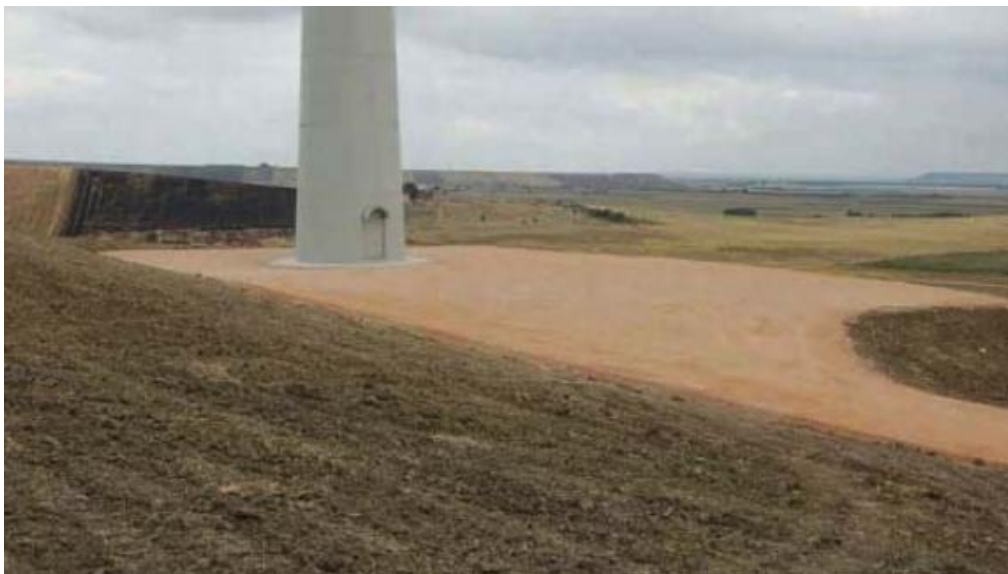
Figura 7. Sistemazione finale di una piazzola-tipo di un aerogeneratore.
