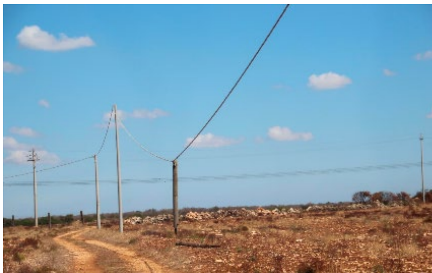
Fig.9 : Foto di una connessione aerea che verrà demolita
