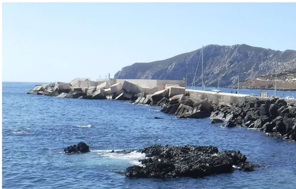
Fig. 3.5 - Foto dello stato attuale nel tratto di mantellata da ricaricare.
