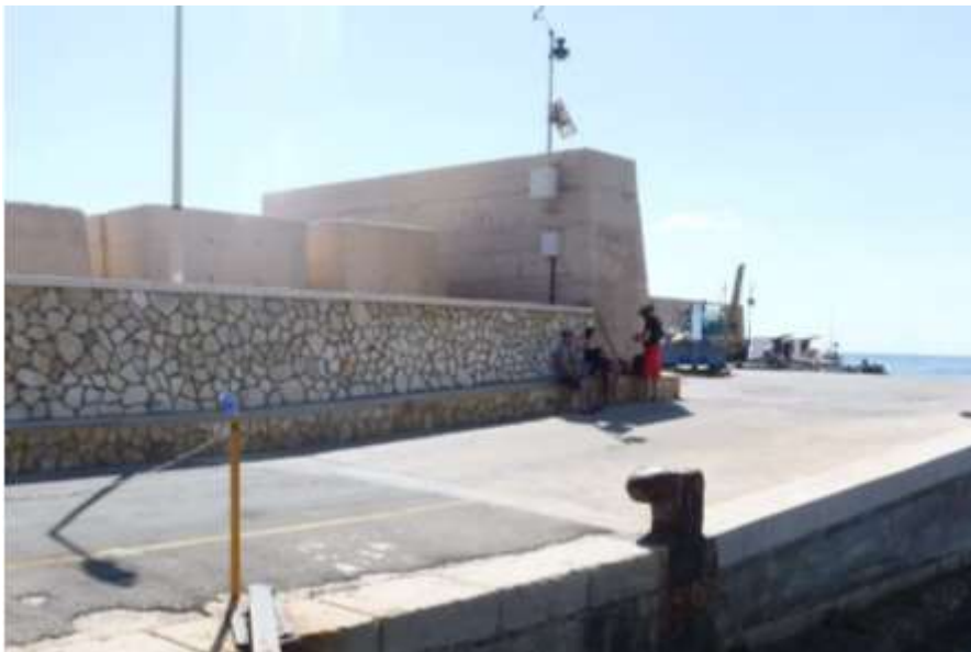
Fig. 4.7 - Inizio tratto muro paraonde a quota + 6,30 s.l.m. (tratto non rivestito fino alla testata).
