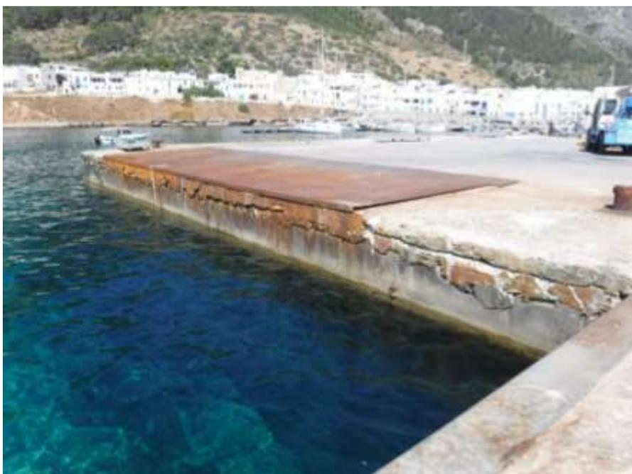
Fig. 2.8 - Banchina per attracco navi traghetto (attracco di poppa) e sullo sfondo pontile galleggiante per imbarcazioni da diporto.
