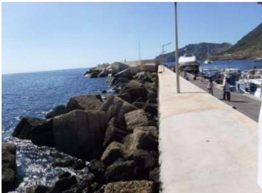
Fig. 2.5 - Tratto di molo da sottoporre a ricarica della mantellata esterna (quota sommitale muro: + 3,5 s.l.m.).
