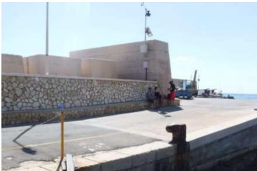
Fig. 2.7 - Inizio tratto muro paraonde a quota + 6,30 s.l.m. (tratto non rivestito fino alla testata).
