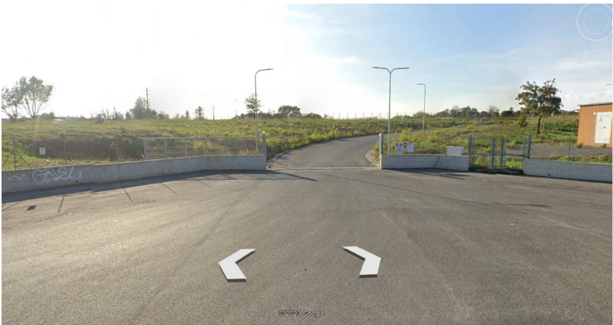
FOTO DELL'ACCESSO I.1 – VIA ANGUILLARESE 537
