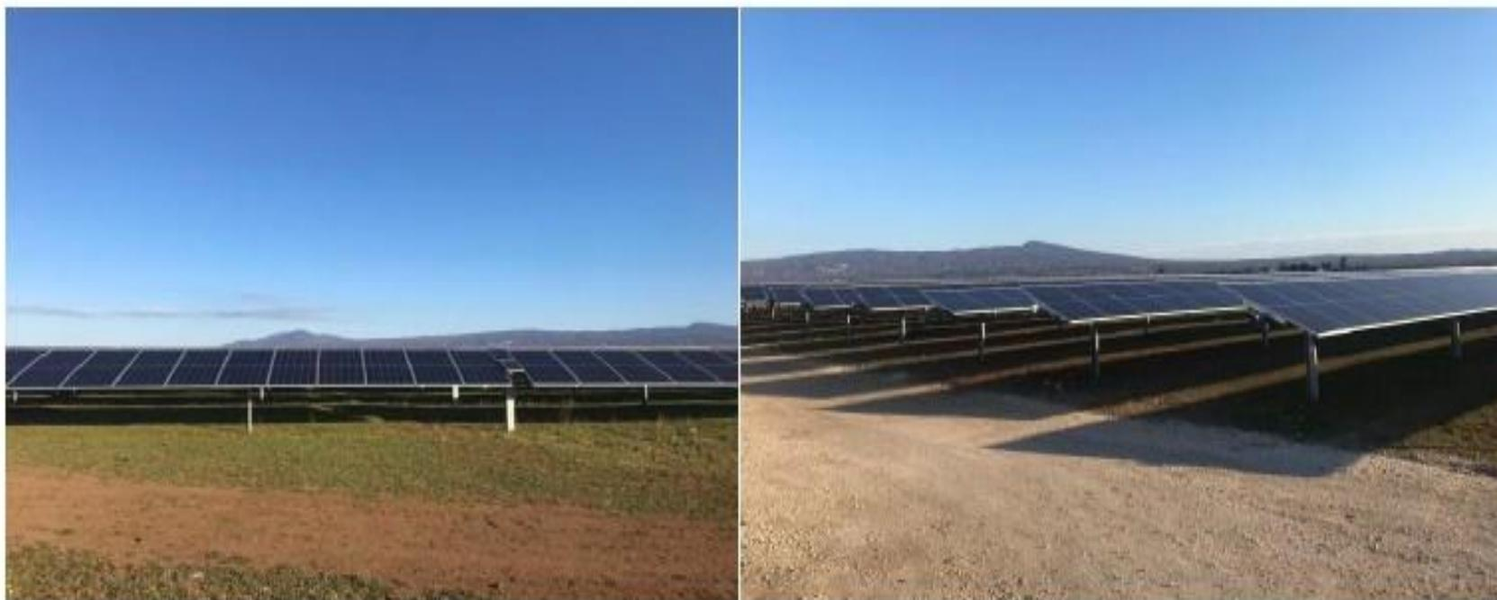
*Figura 33: Esempi di impianti con tecnologia ad inseguimento tracker*
