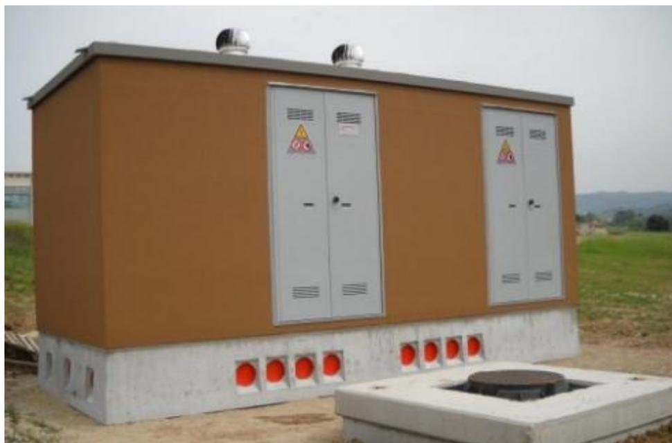
*Figura 36. Foto di un esempio delle cabine prefabbricate dell'impianto in c.a.v. (che potranno essere alternativamete utilizzate alle cabine prefabbricate in metallo di cui alla Figura 35)*
