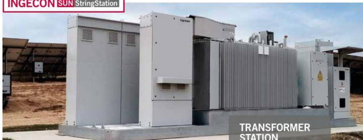
*Figura 33. Foto di esempio delle cabine prefabbricate dell'impianto in c.a.v. o in metallo del tipo Solar Transformer Station)*
