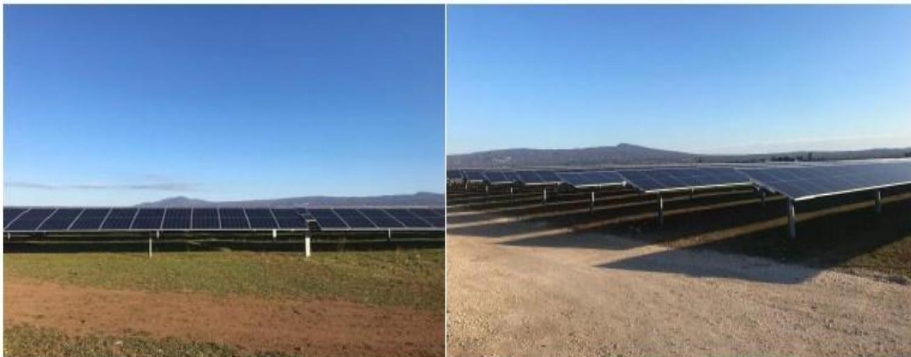
*Figura 31: Esempi di impianti con tecnologia ad inseguimento tracker*
