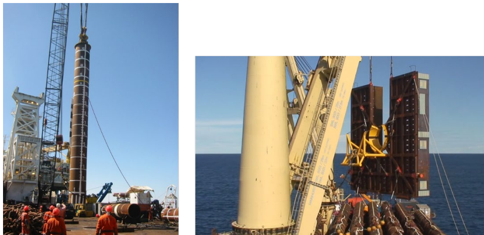
Figura 26: Pali battuti (a sinistra) e modalità di installazione (a destra).
