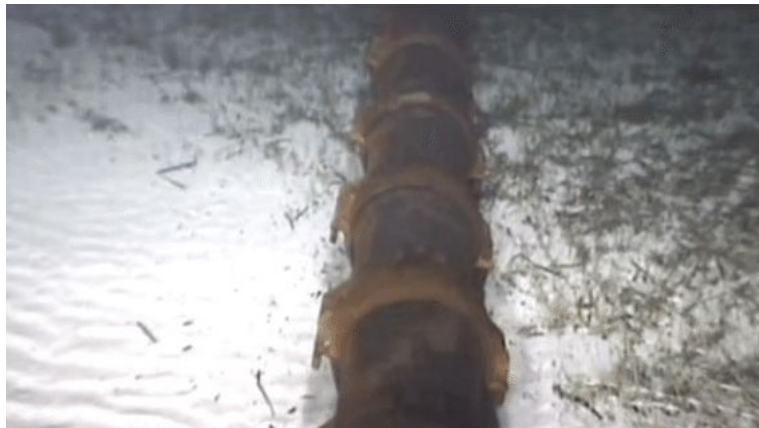
Figura 32: Esempio di protezione dei cavi con gusci di ghisa. Source: ResearchGate, F.Palone et al., Malta-Sicily Interconnector.
