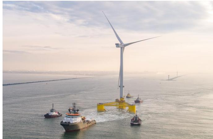
**Figura 2: Immagine tipo di traino fondazione galleggiante - aerogeneratore.**
