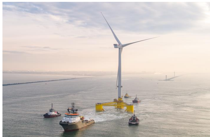
Figura 142: Immagine tipo di traino fondazione galleggiante - aerogeneratore.
