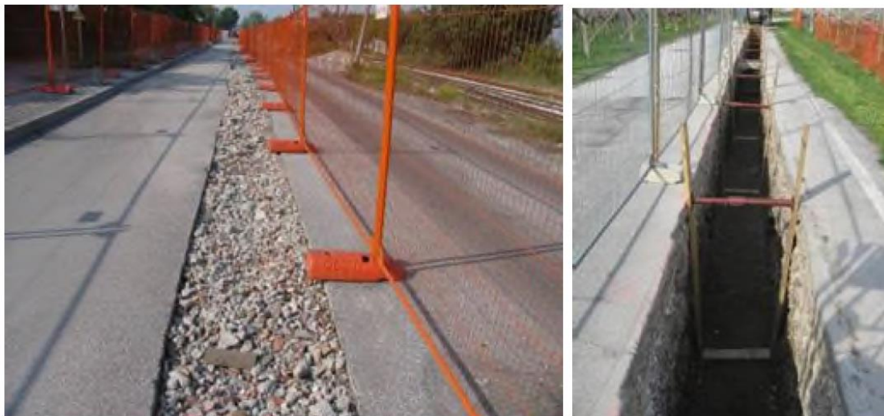
Figura 155: Taglio dell'asfaltatura e scavo aperto.
