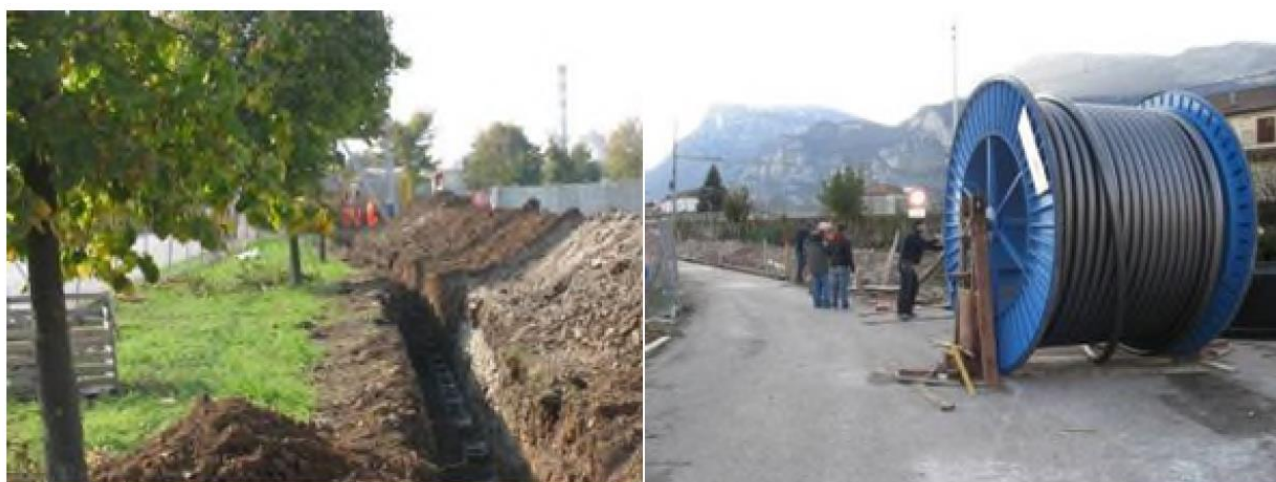
Figura 156: Posa rulli lungo lo scavo e stendimento del cavo.
