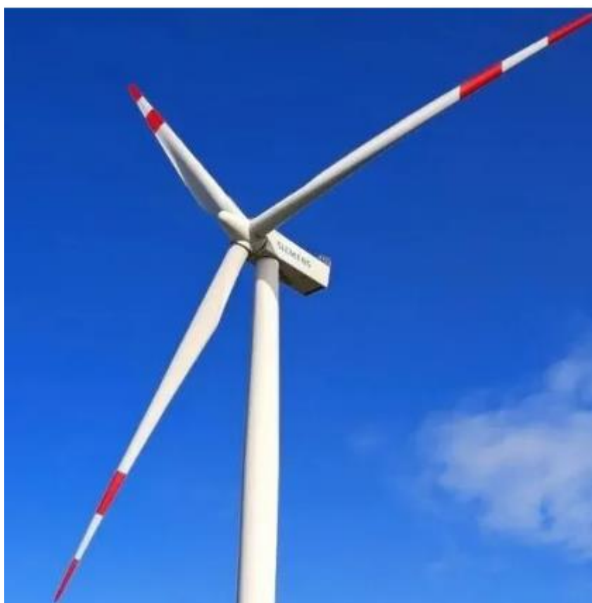
Figura 88: Esempio di una generica turbina con bande bianche e rosse (Fonte: https://windmillstech.com/why-wind-turbines-are-painted-with-red-stripes/ ).
