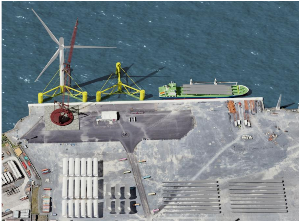
Figura 141: Immagine tipo del cantiere di integrazione aerogeneratore/fondazione galleggiante.
