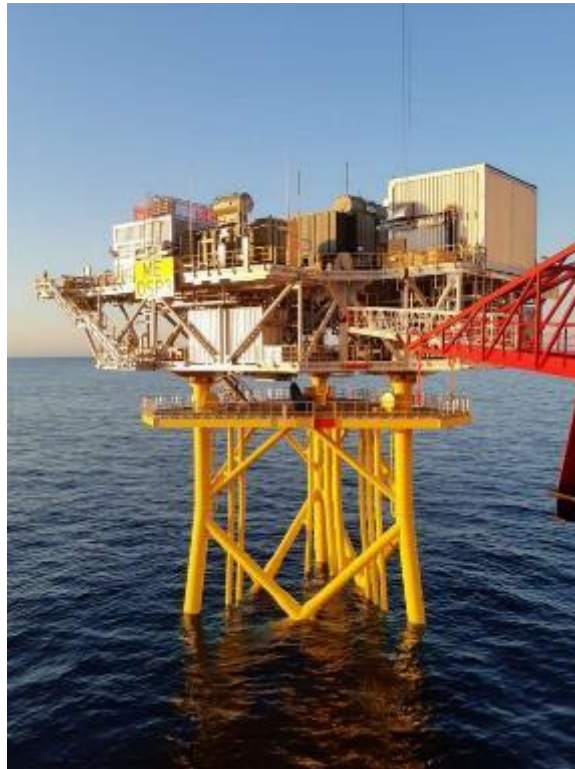
Figura 10: Esempio di topside con componenti elettrici.
