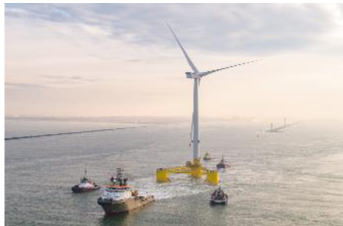
Figura 27: Immagine tipo di traino fondazione galleggiante - aerogeneratore.
