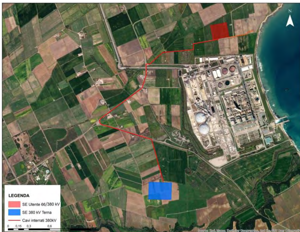
Figura 17: Cavo interrato di connessione 380 kV tra la Stazione Elettrica Utente 66/380 kV e la Stazione RTN 380 kV.
