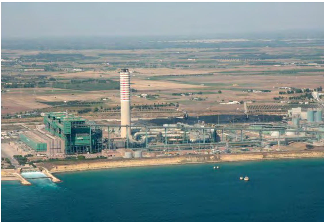
Figura 52: Centrale ENEL di Cerano, la falesia su cui poggia l'impianto presenta forti segni di degrado ed è scavata al piede (Fonte: PPTR Puglia).
