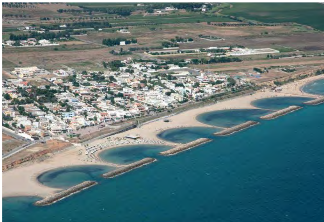
Figura 53: San Pietro Vernotico, opere di difesa longitudinale costruite per contrastare il fenomeno di erosione costiera in atto (Fonte: PPTR Puglia).
