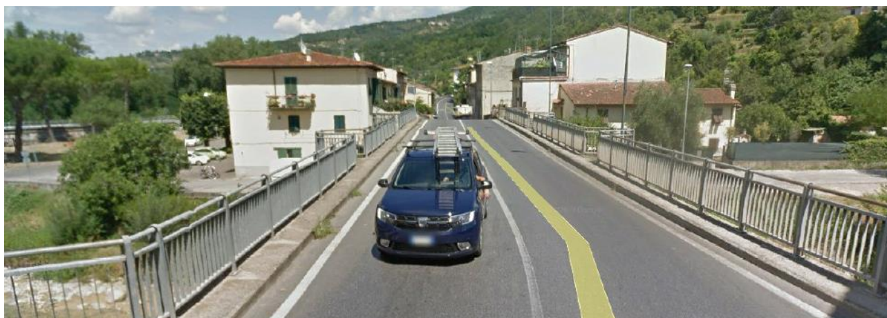
Figura 12 Attraversamento fluviale lungo il tragitto esistente
