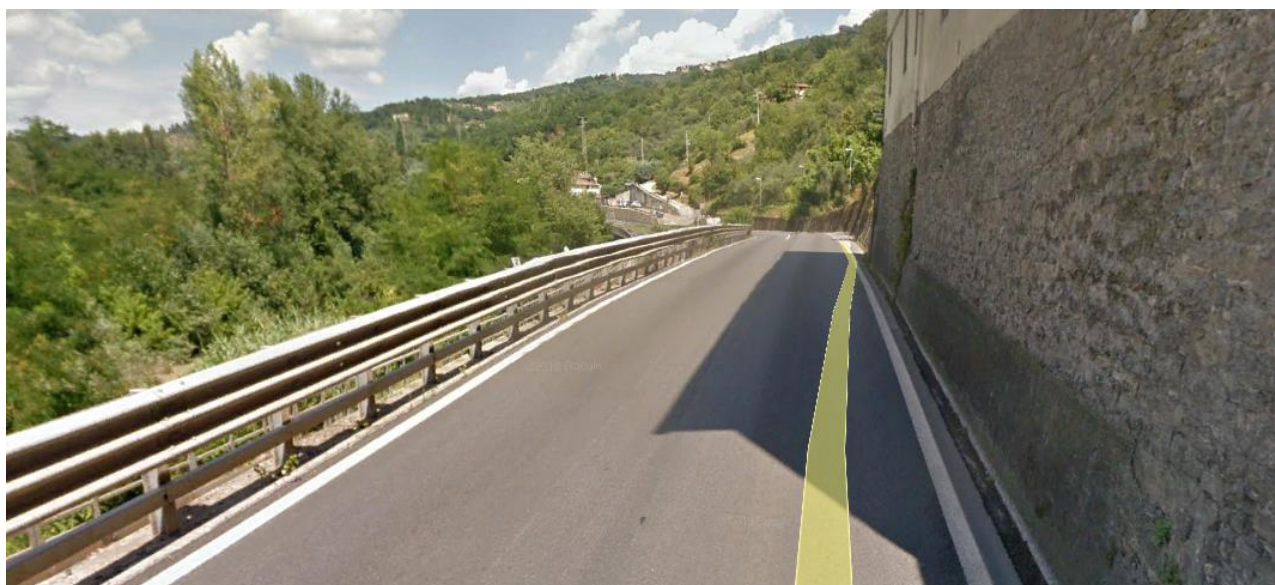
Figura 13 Tratto caratterizzato dalla presenza di un edificio a ridosso della strada
