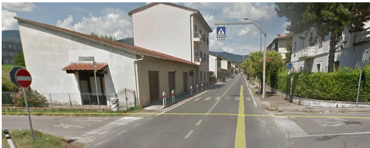
Figura 8 Passaggio interno al centro abitato con attraversamenti pedonali e intersezione a raso
