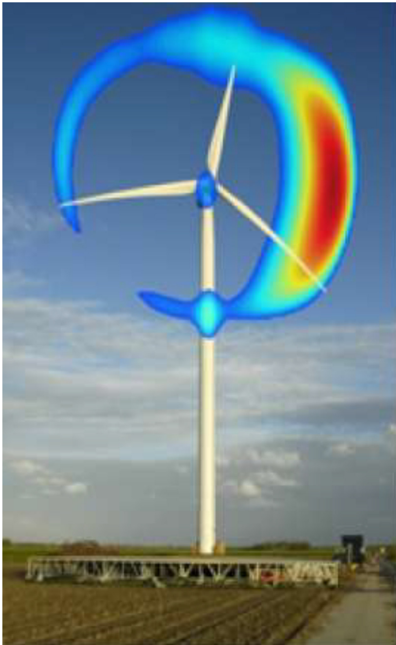
Rumore rilevato con SISTEMA BEAMFORMING
