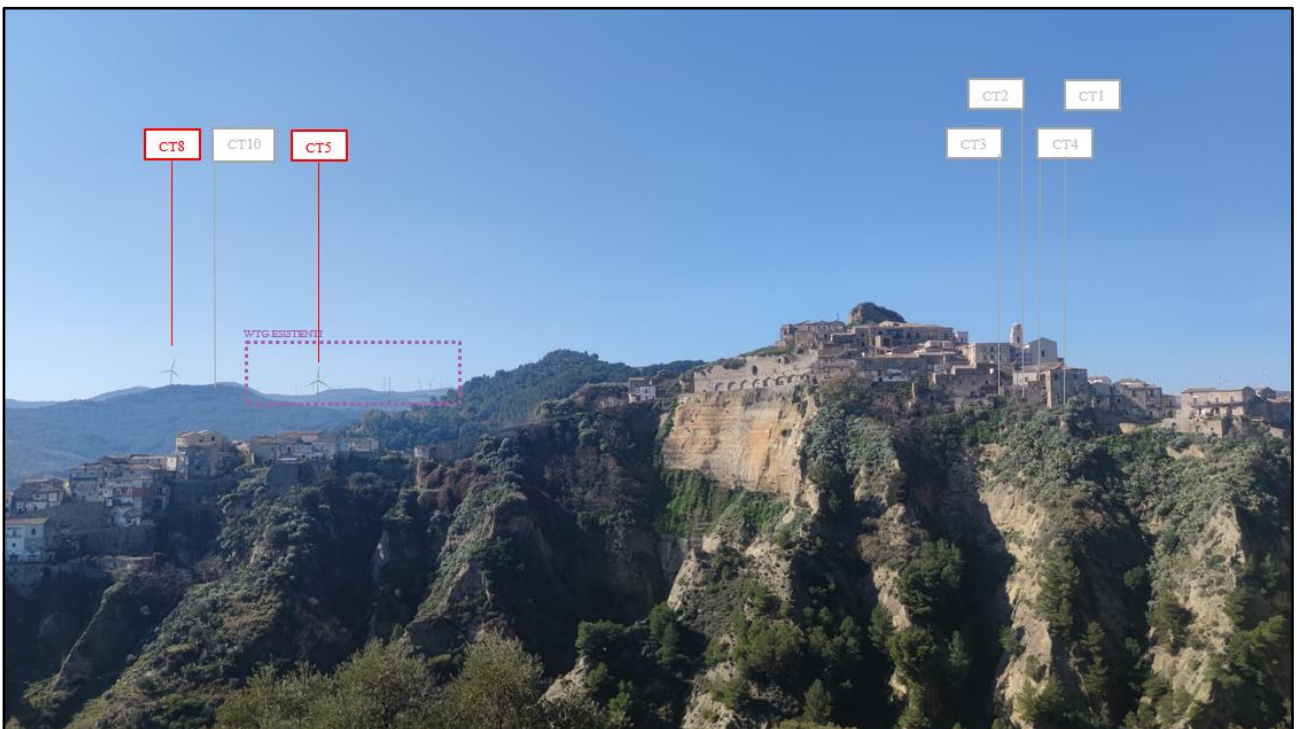
Figura 11.9: Complesso Conventuale di S.Francesco, Comune di Tursi- punto di ripresa fotografica P14 - Long. 16,475486°, Lat. 40,250735° - Vista area CT1, CT2, CT3, CT4, CT5, CT8, CT10 post operam — CT5. CT6. CT7. CT8 sono VISIBILI. Tutti gli altri aerogeneratori non sono visibili per orografia del terreno o presenza di ostacoli (edifici).
