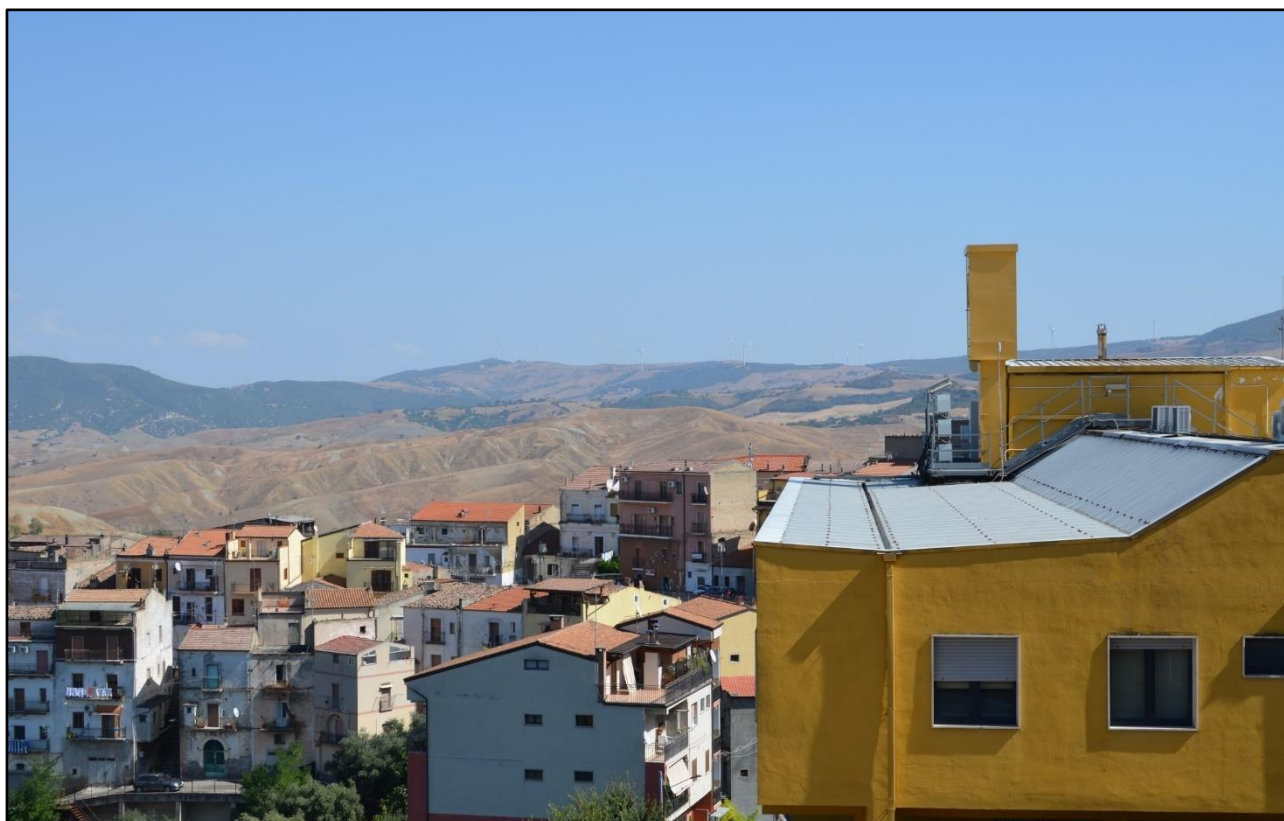
Figura 11.11: Punto panoramico, Piazza Roma, Comune di Sant’Arcangelo - punto di ripresa fotografica P24 - Long. 16,274383°, Lat. 40,246600° - Vista area CT1, CT2, CT3, CT4, CT5 ante operam
