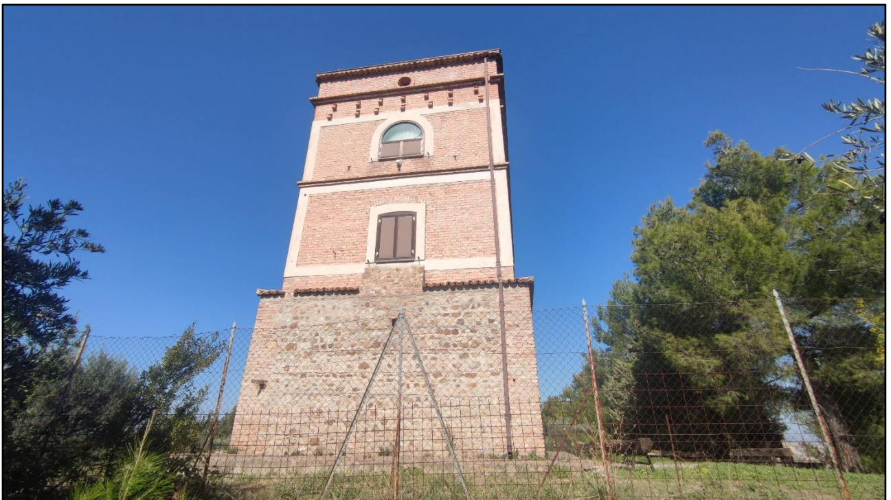
Foto 7.1.4.12: Torre Molfese nel Comune di Sant'Arcangelo
