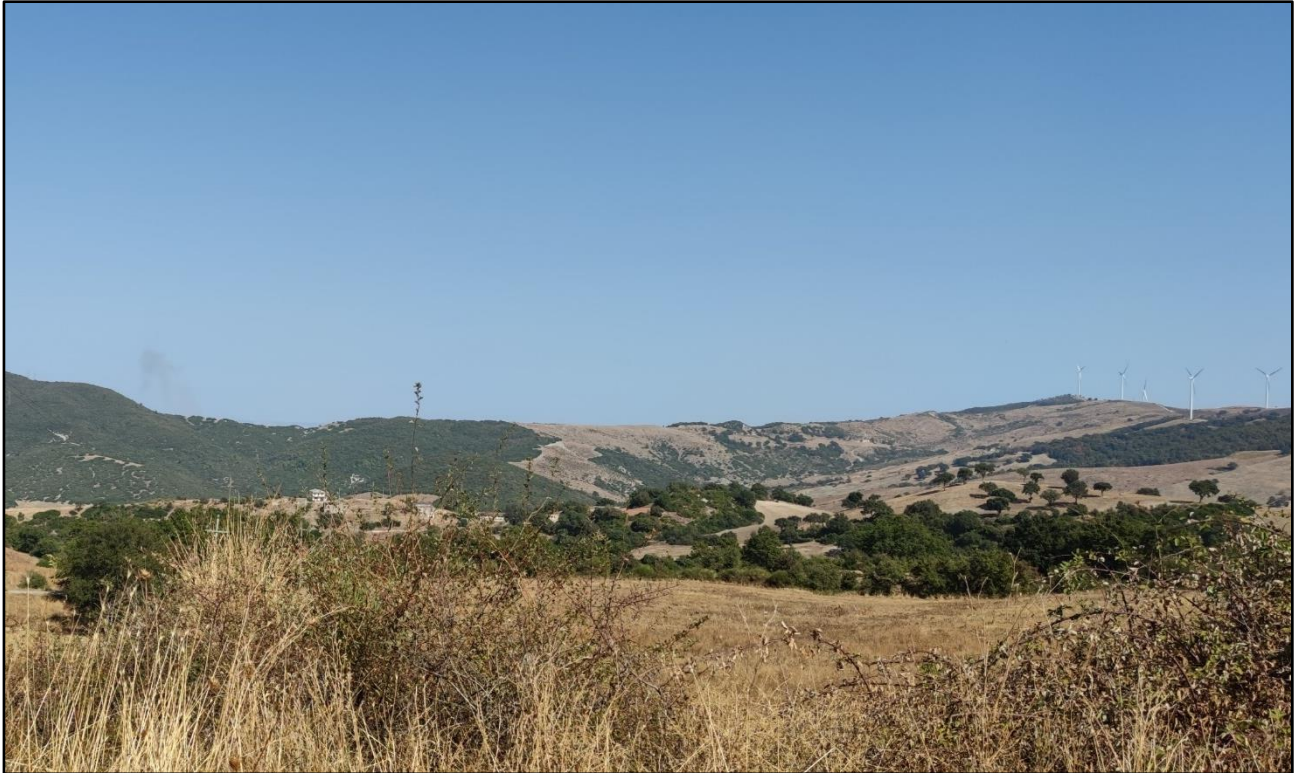
Figura 11.2: Masseria Molfese, Comune di Sant’Arcangelo- punto di ripresa fotografica P2 Long. 16,350983°, Lat. 40,247650°- Vista area CT1, CT2, CT3, CT4 ante operam.
