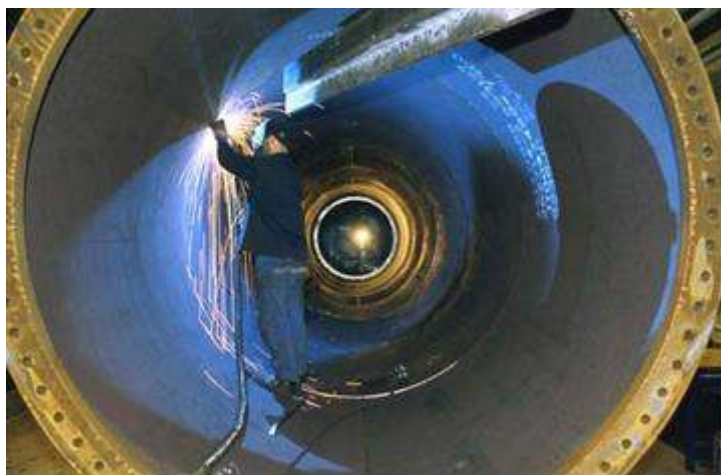
Figura 17: interno di una torre
