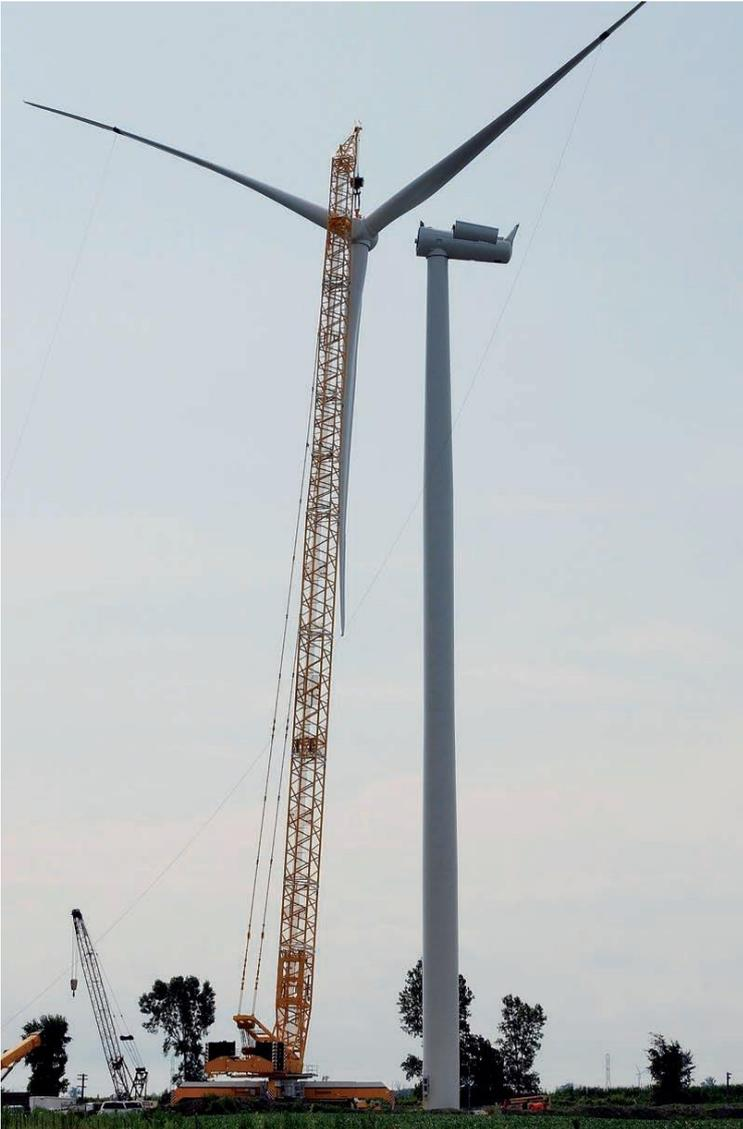
Figura 5-1 - Una gru Liebherr 1750 mentre solleva un gruppo rotore per l'installazione.
