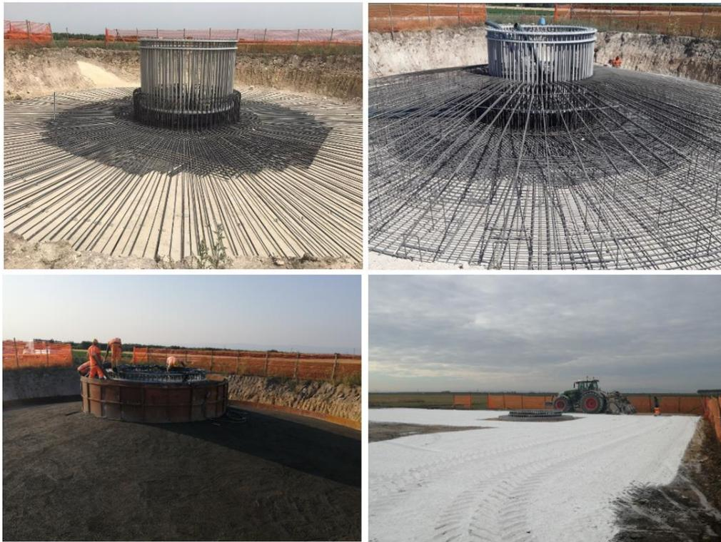
Figura 13 - Principali fasi posa in opera plinto
