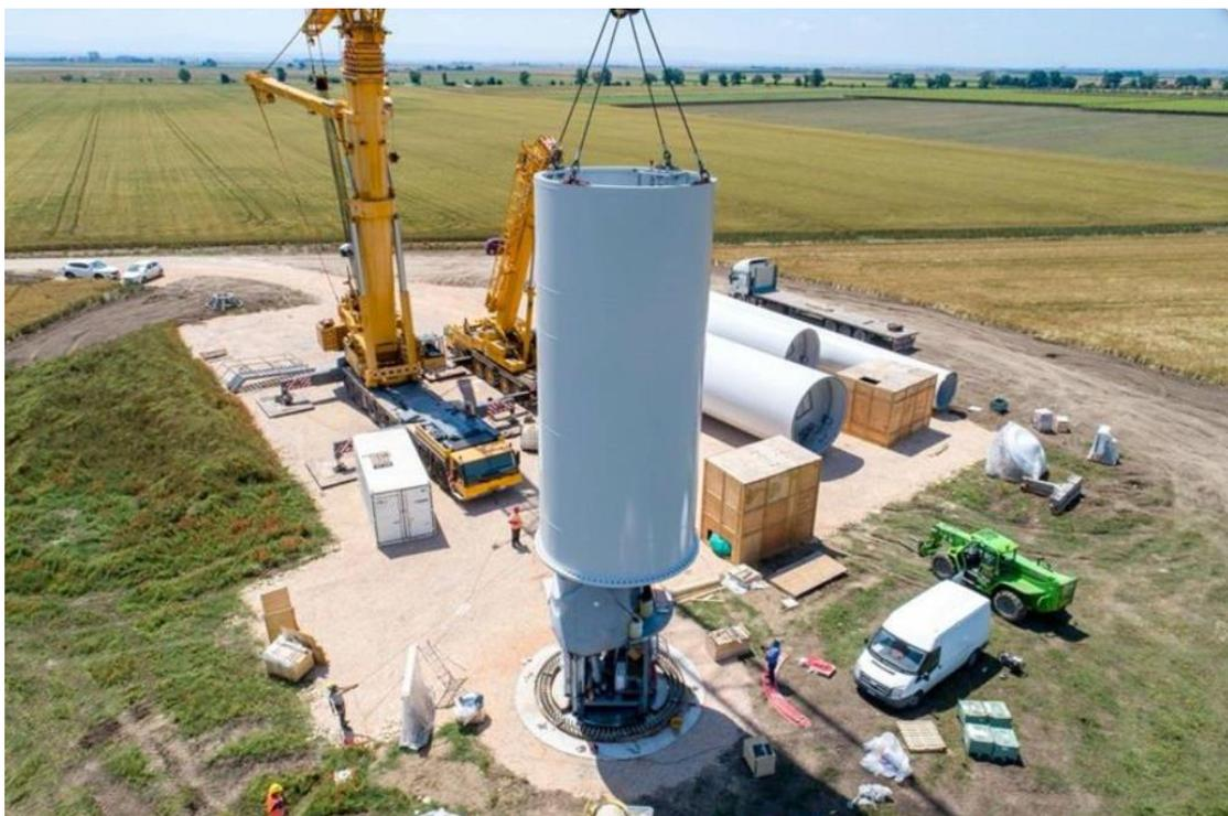
Figura 14 - Montaggio primo tronco della torre
