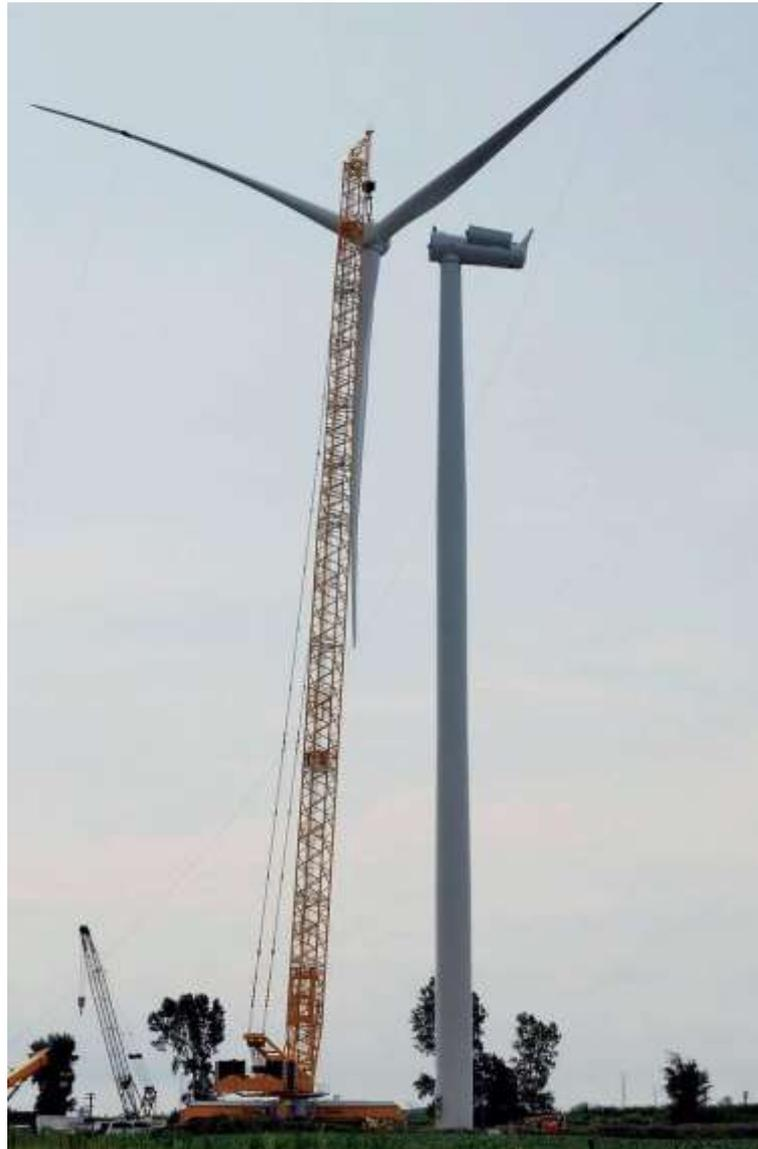
Figura 4-13: Una gru Liebherr 1750 mentre solleva un gruppo rotore per l'installazione
