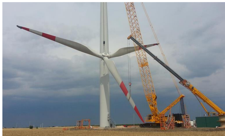
Figura 55 – Montaggio pale.
