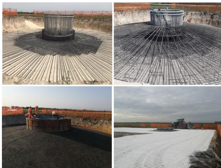
Figura 53 - Principali fasi posa in opera plinto.
