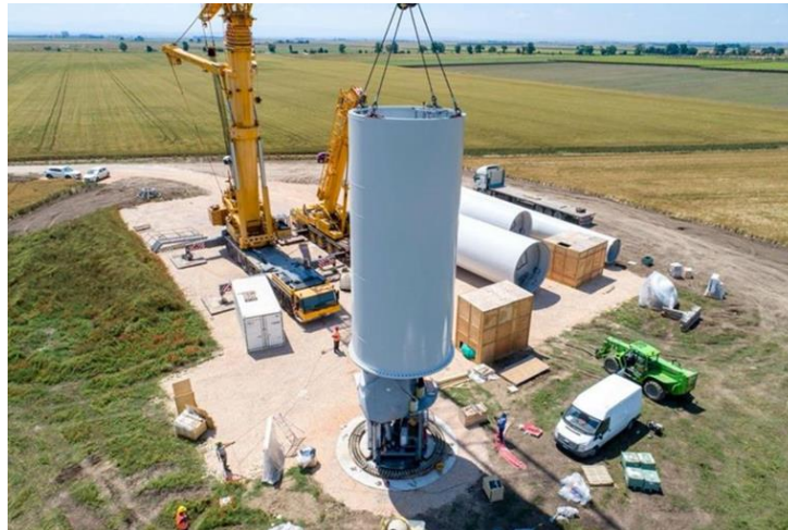
Figura 54 – Montaggio primo tronco della torre.
