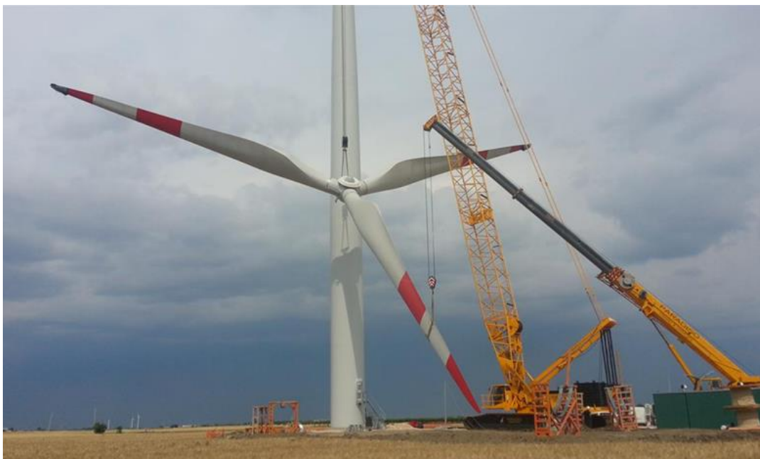
Figura 2—17 – Montaggio pale.
