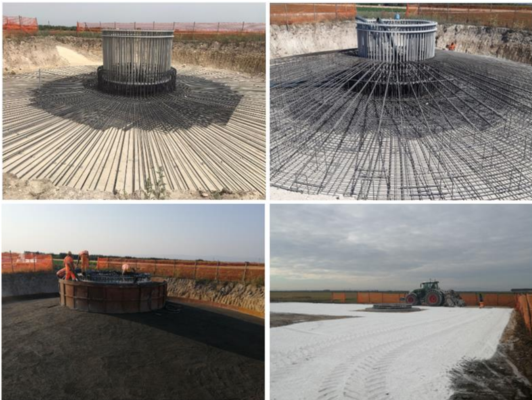
Figura 2—15 - Principali fasi posa in opera plinto.
