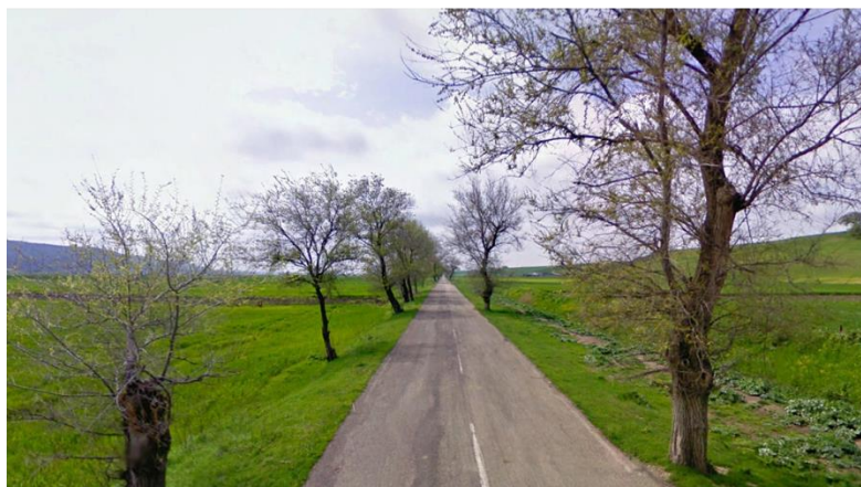
Figura 2—29 OB5 ; ortofoto e visuale stradale.
