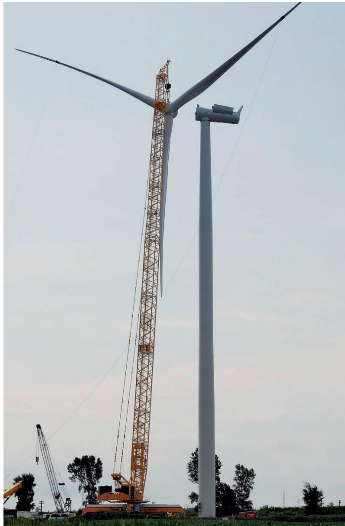
Figura 2-9: Una gru Liebherr 1750 mentre solleva un gruppo rotore per l'installazione
