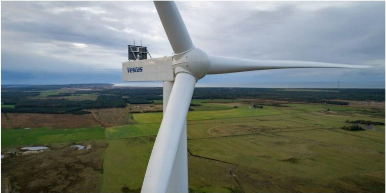
Figura 2—6: Aerogeneratore Vestas Enventus 172 da 6,6 MW di potenza
