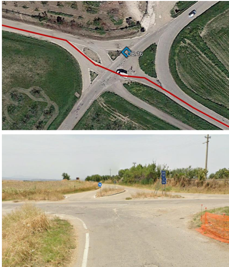
Figura 2—35 OB16 ; ortofoto e visuale stradale.
