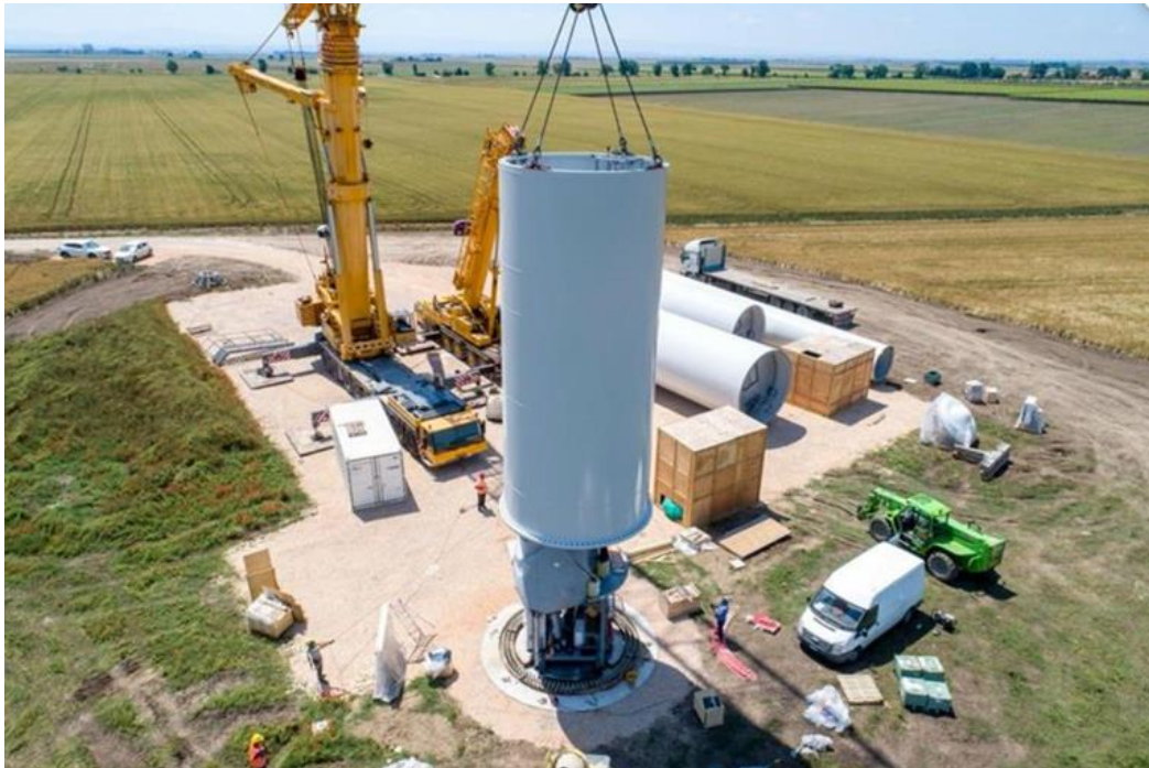
Figura 2—16 – Montaggio primo tronco della torre.
