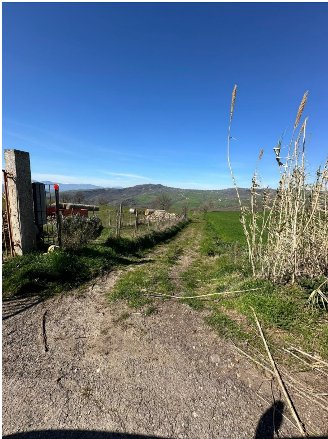
Figura 31 – Ripresa fotografica dal punto di vista numero 28, verso le postazioni CA05 e CA06. Viabilità oggetto di adeguamento.
