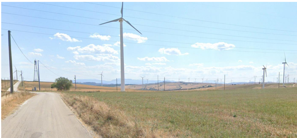
Figura 42 – Ripresa fotografica dal punto di vista numero 39. Ambito di passaggio del cavidotto di collegamento impianto-SSEU.
