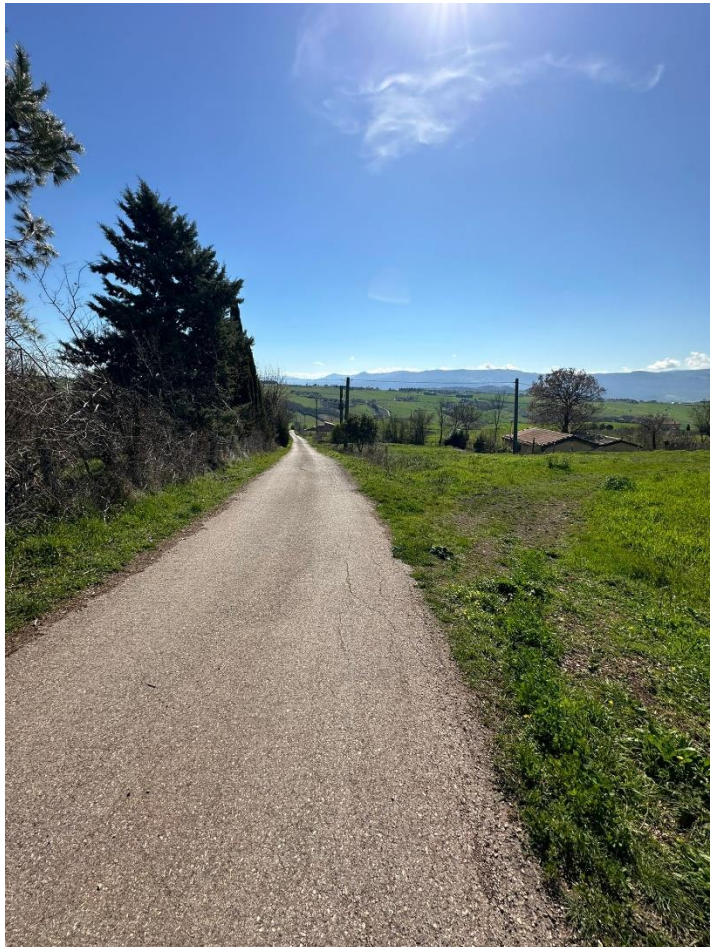
Figura 20 – Ripresa fotografica dal punto di vista numero 17. Viabilità temporanea di cantiere.
