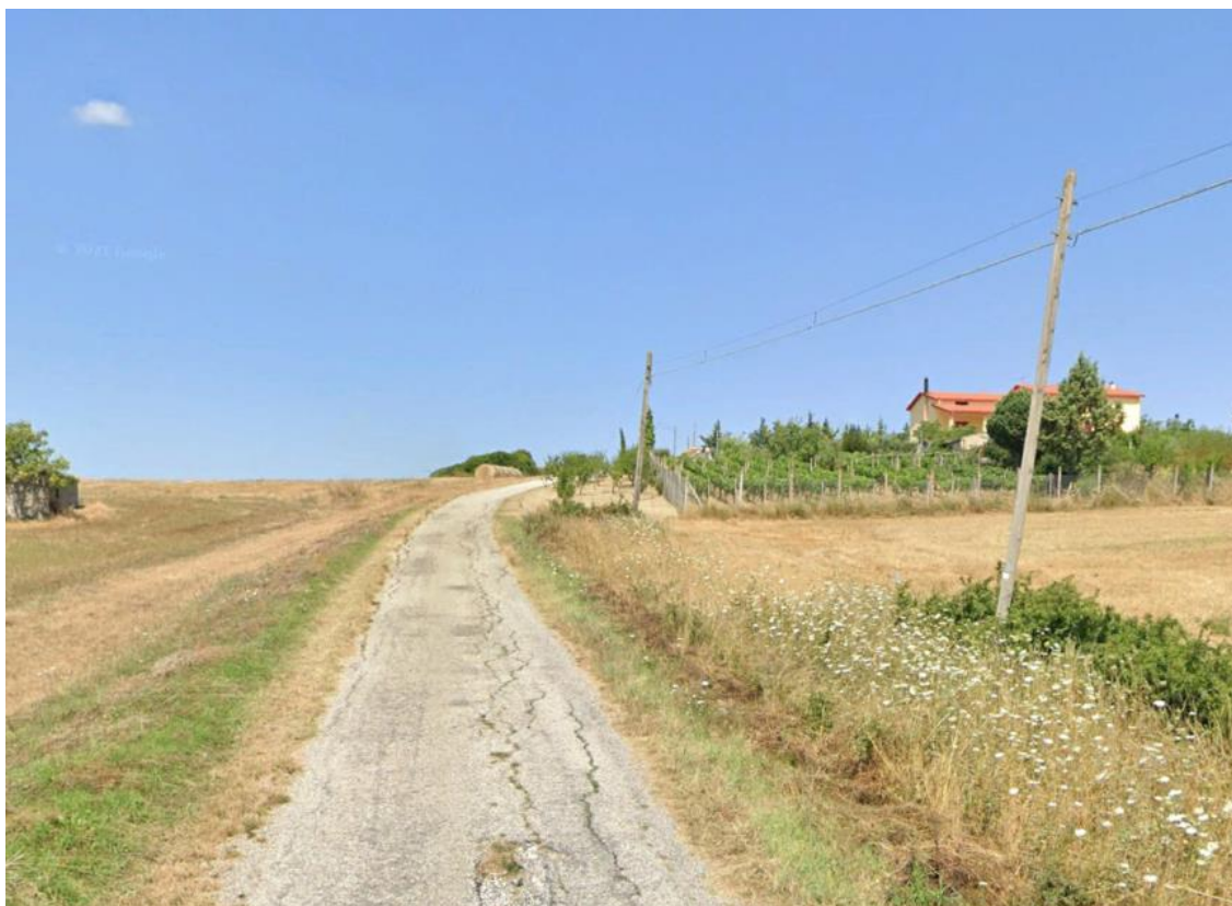
Figura 24 – Ripresa fotografica dal punto di vista numero 21. Viabilità temporanea di cantiere.
