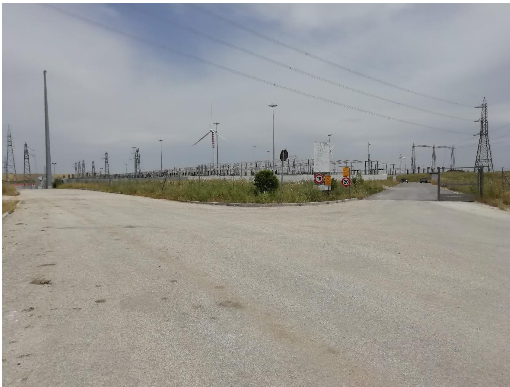
Figura 45 – Ripresa fotografica dal punto di vista numero 42. Stazione Elettrica Terna "Bisaccia".
