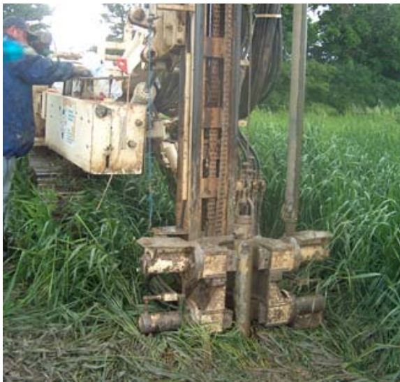
Area di sondaggio
