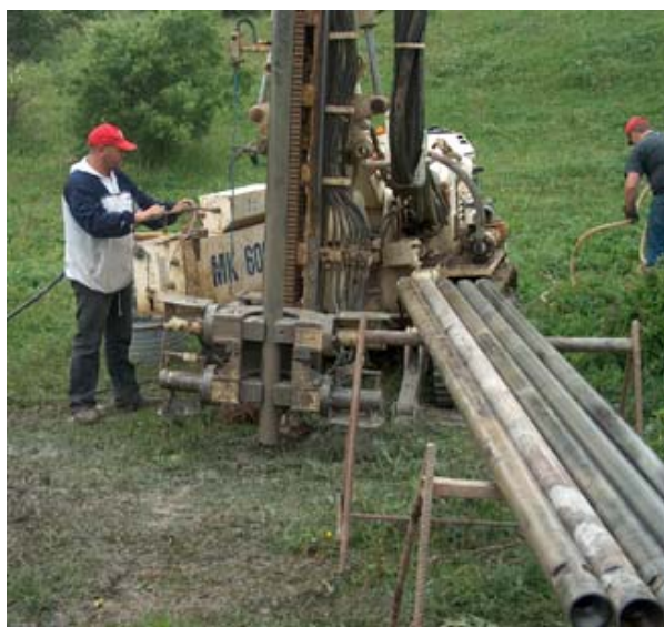
Area di sondaggio
