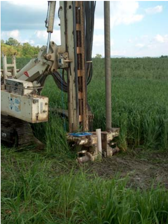
Area di sondaggio
