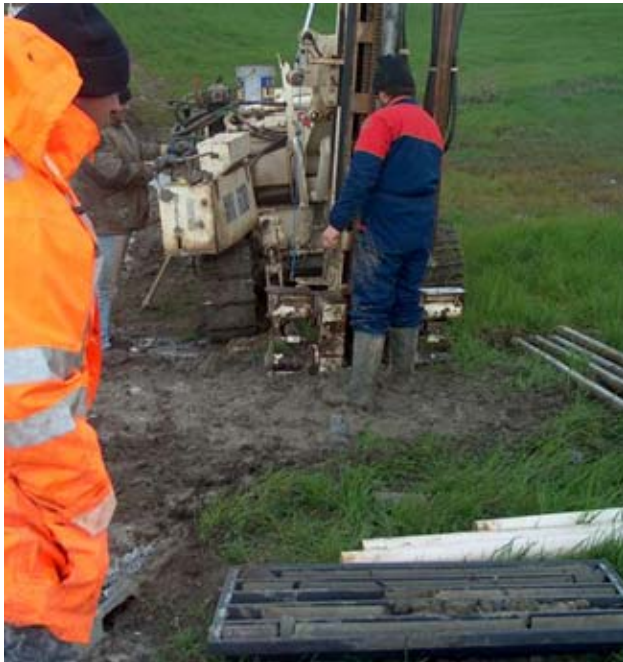
Area di sondaggio
