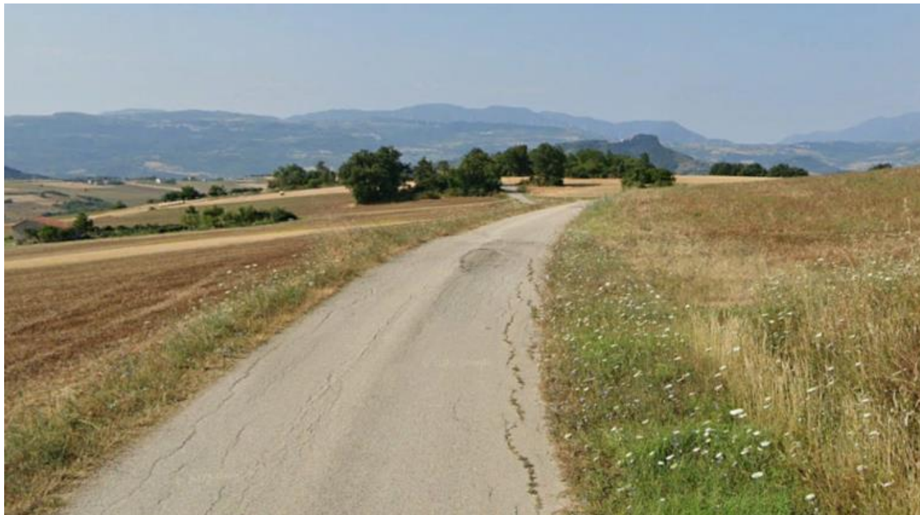
Figura 5-8: Strada vicinale della Chianca, in direzione delle postazioni CS04, CS05 e CS06
