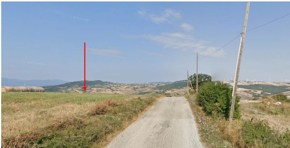
Figura 5-6: Viabilità esistente, in prossimità della postazione CS02 (prevista indicativamente nella posizione della freccia rossa)
