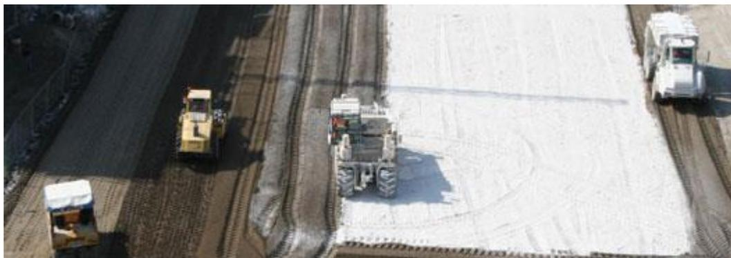
Oltre la corretta applicazione della metodologia, occorre l'utilizzo di appositi macchinari progettati e costruiti allo scopo, quali la stabilizzatrice (Pulvimixer), lo spandi-calce a dosaggio regolabile, i rulli a piastre vibranti ed i rulli gommati di adeguato peso.
