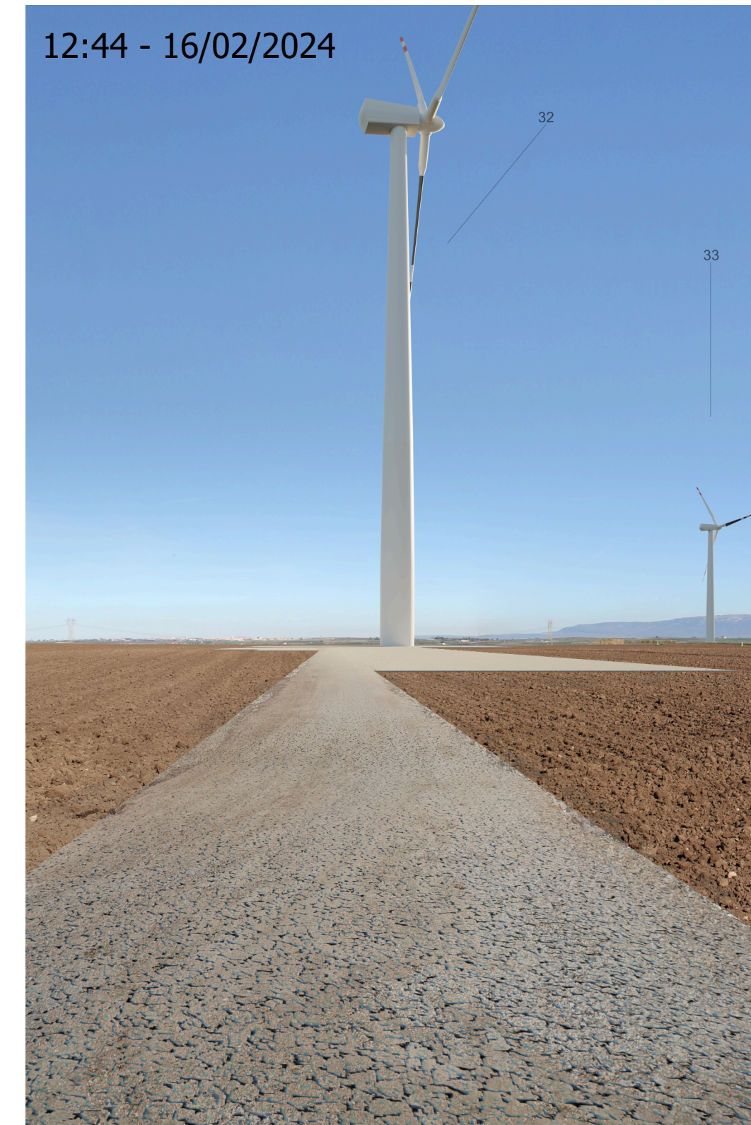
Stato di cantiere
