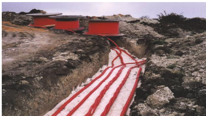
Figura 10: Installazione Cavidotto
