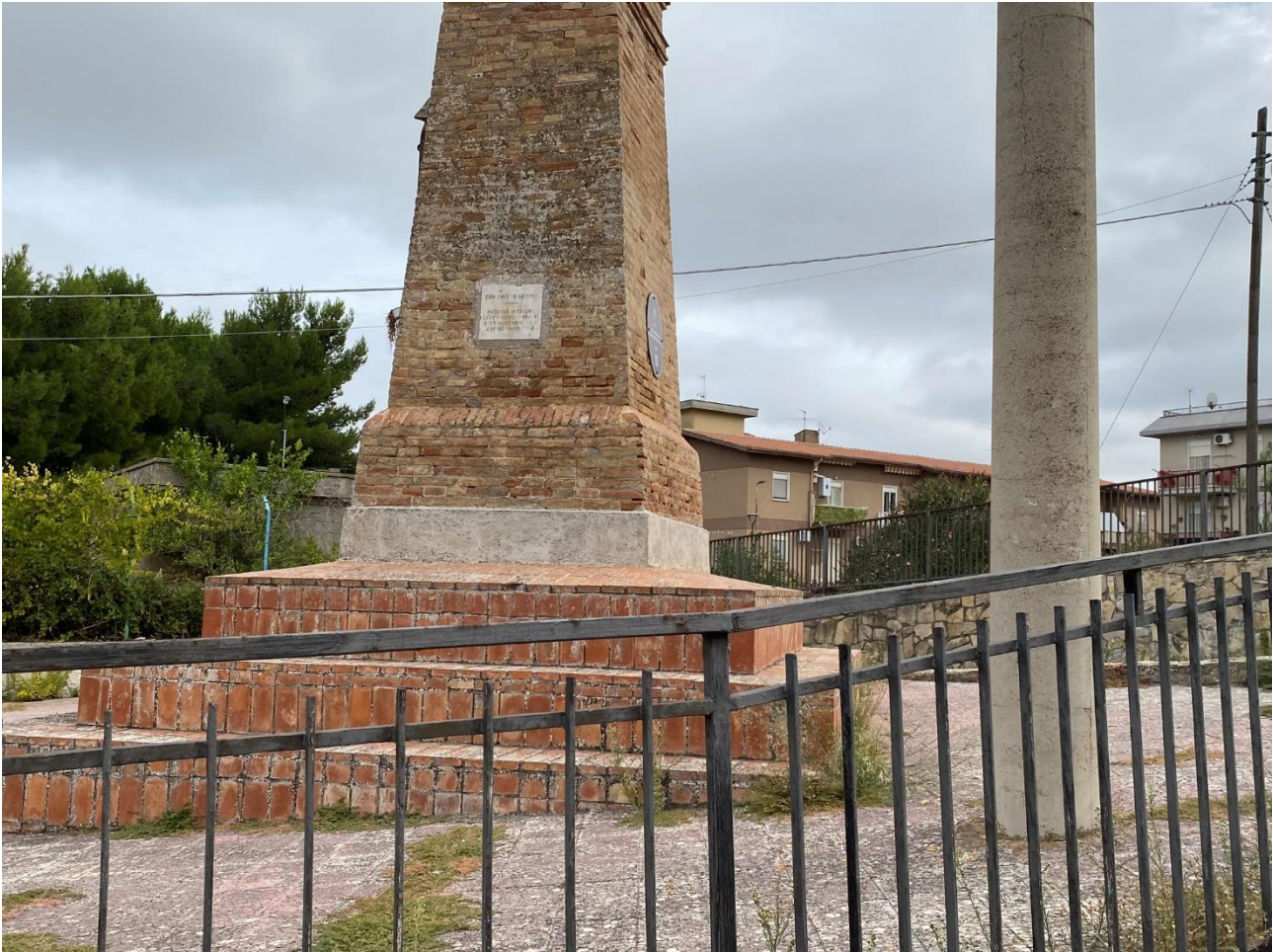
Figura 68 – Stato di fatto
